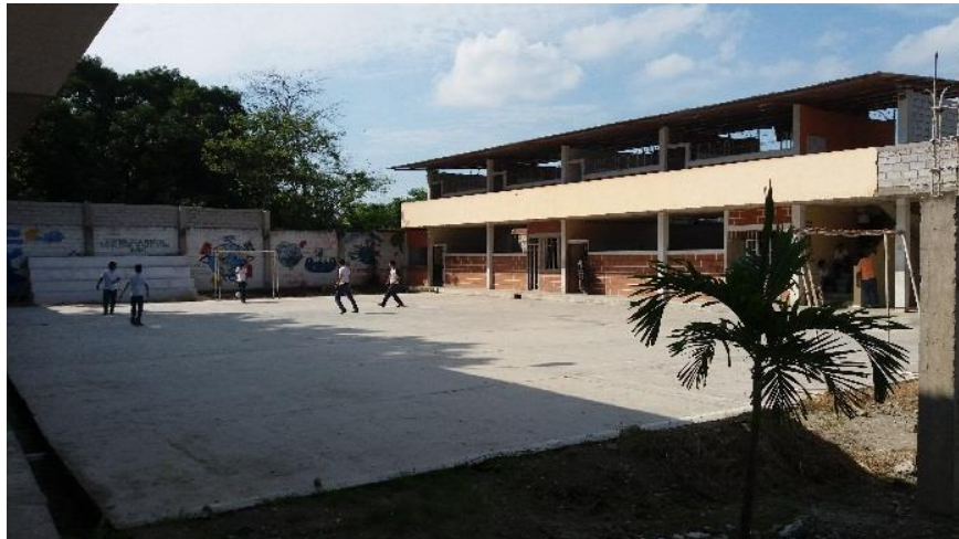
Vista general interna de la institución
