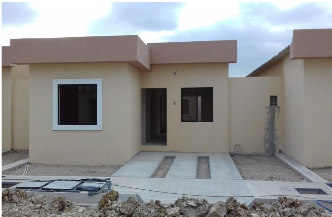
Figura: vivienda en construcción
