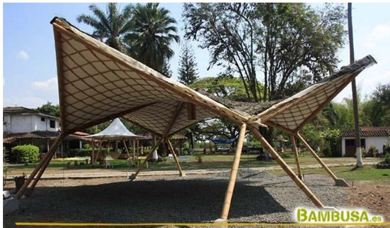
Los materiales utilizados para las membranas son tejidos de poliéster a los que se van agregando capas superiores e inferiores de PCV en número de hasta dos por lado con distintos espesores, dependiendo de la aplicación y una capa final de teflón
