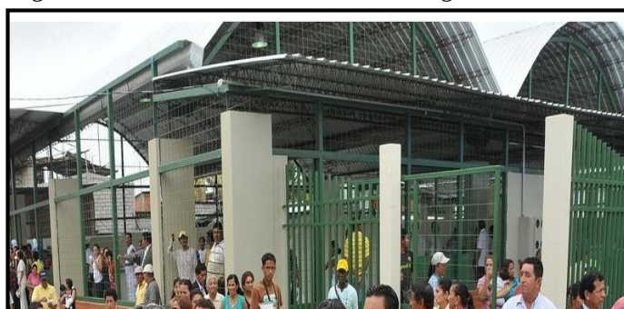
Figura 72: Vista exterior del Mercado de Yaguachi
