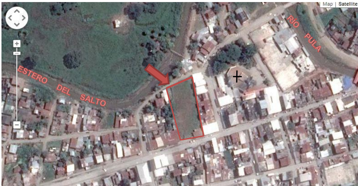
Figura 42. Vista aérea del terreno
