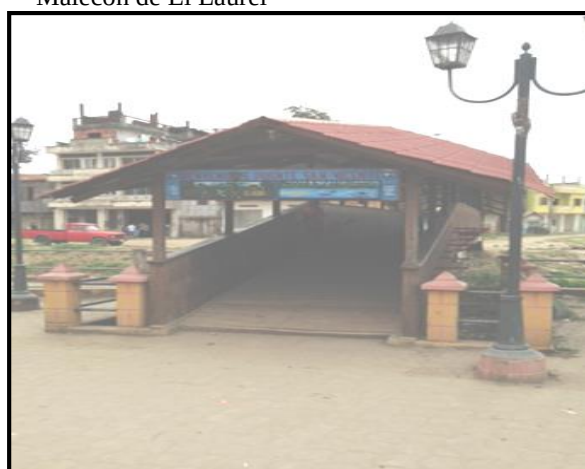
Figura 25. Puente San Vicente ubicado en el Malecón de El Laurel
