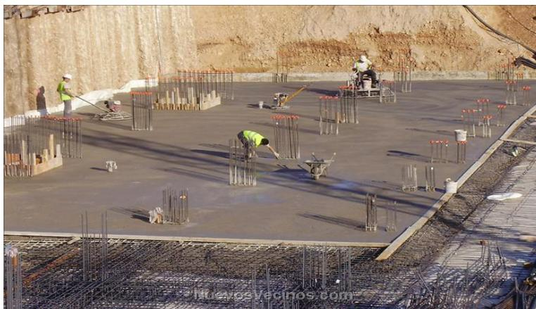
Se denomina como losas a los elementos estructurales bidimensionales, en donde la tercera dimensión es pequeña comparada con las otras dos dimensiones básicas. Estas losas actúan por flexión, ya que las cargas que actúan sobre estas son fundamentalmente perpendiculares al plano principal de las mismas. Se pueden distinguir varios tipos de losas; según el tipo de apoyo se pueden encontrar, Según la dirección de trabajo y según la distribución interior del hormigón.
