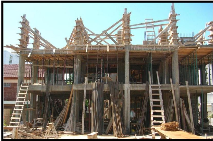
La técnica constructiva del hormigón armado consiste en la utilización de hormigón reforzado con varillas o mallas de acero, llamadas armaduras.
