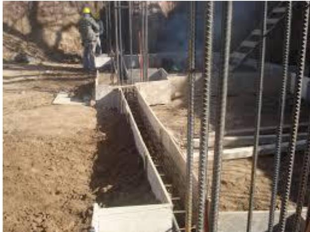
Las vigas riostras, de atado o de arriostamiento, son piezas o elementos estructurales generalmente de hormigón armado o de cualquier elemento que pueda resistir tracciones, que unen dos o más cimientos o zapatas.
