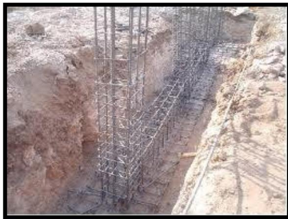
Es un elemento estructural que soporta las cargas de una estructura (puente, edificio, vivienda, muro, etc.) que le son transmitidas a través de las columnas pilotes o elementos estructurales verticales y esta a su vez la transmite al suelo, disipando así las cargas.
