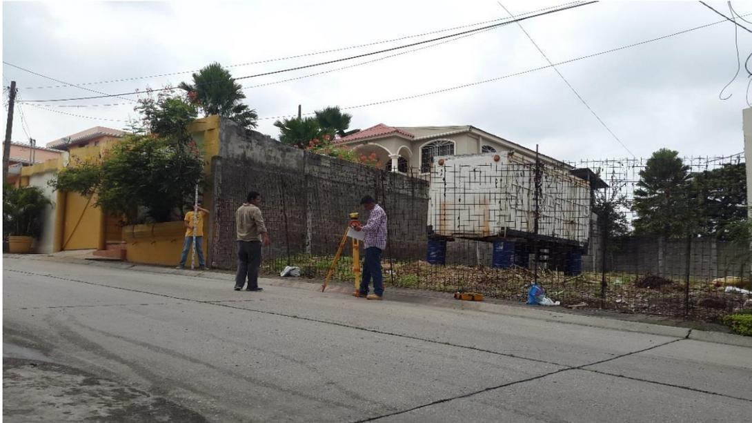
*Imagen 02; Arrastre de nivel con equipo de nivelación.*
