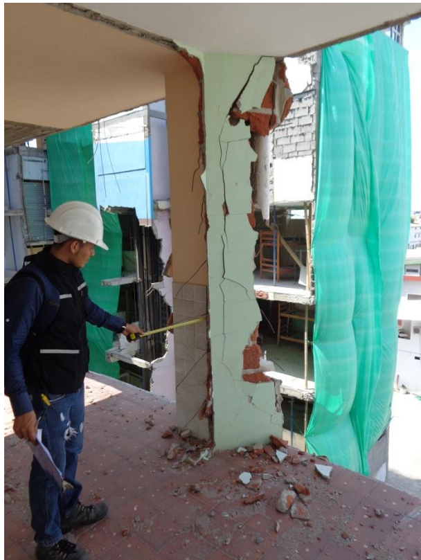
Fotografía #4 Inspección detalles constructivos.
