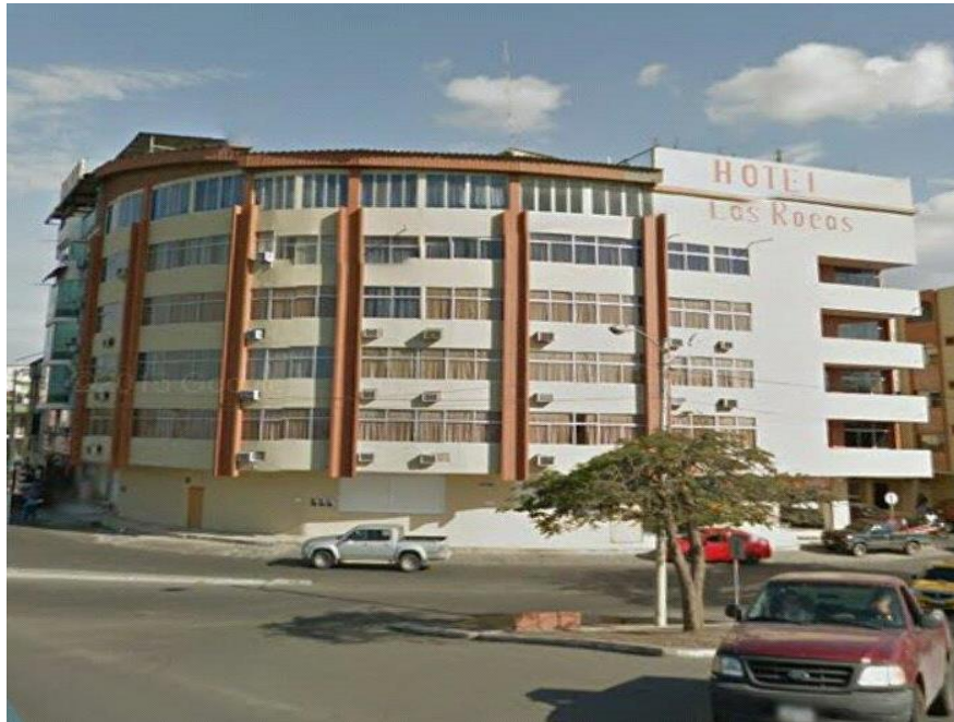
Fotografía #1 Hotel Las Rocas de la ciudad Manta antes del sismo 16 de abril de 2016.
