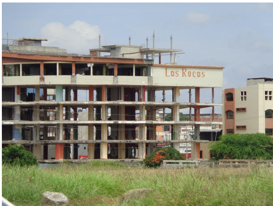
Fotografía #2 Hotel Las Rocas de la ciudad Manta después del sismo 16 de abril de 2016.
