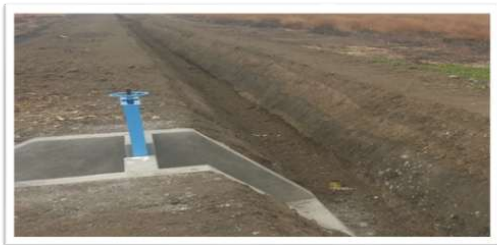
Figura 12: Canales y compuertas
