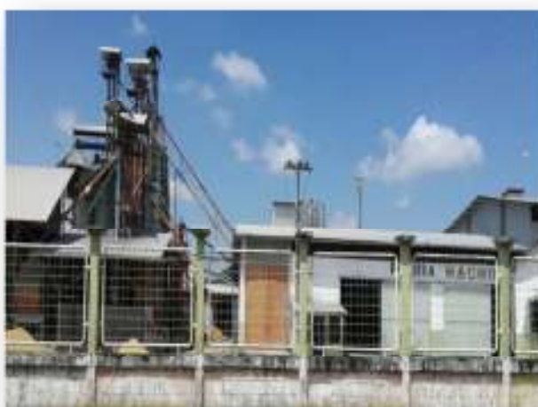
Anexo 8: Infraestructura de la Piladora Nacho
