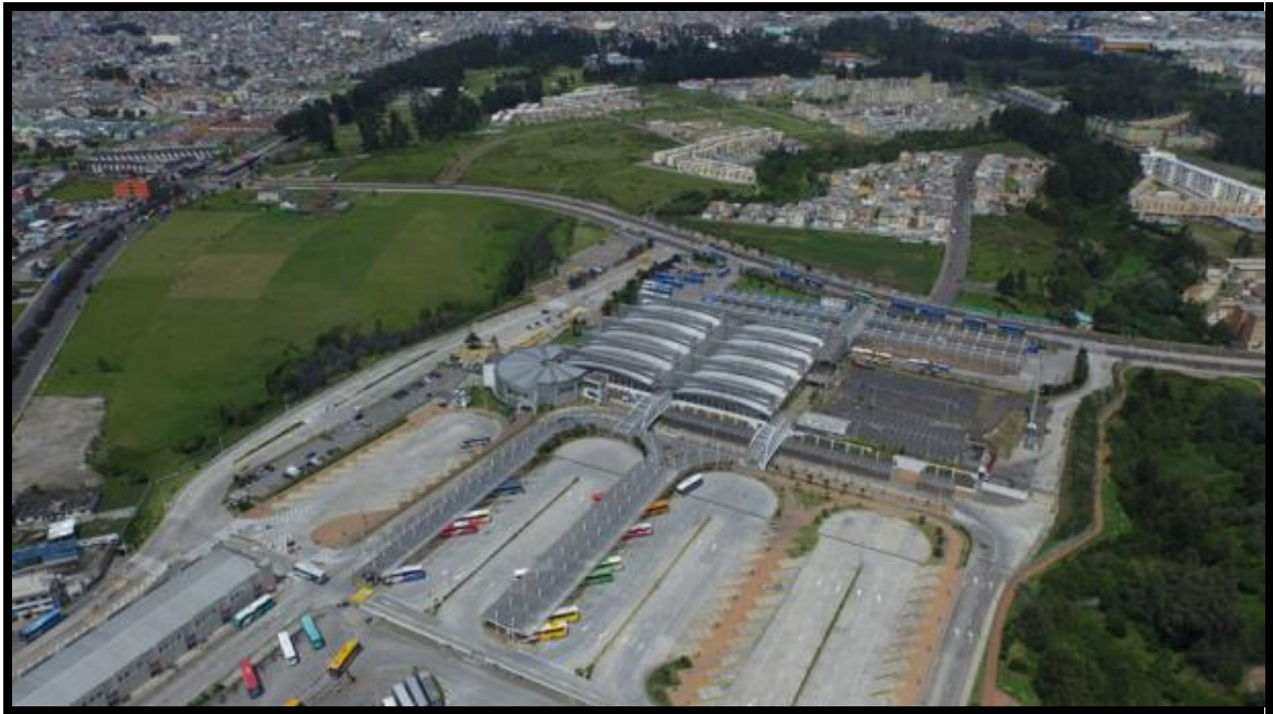
Figura 9 Terminal Terrestre de Quitumbe
