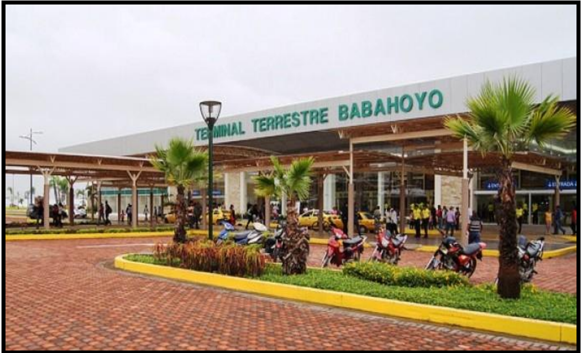
Figura 11 Terminal Terrestre de Babahoyo
