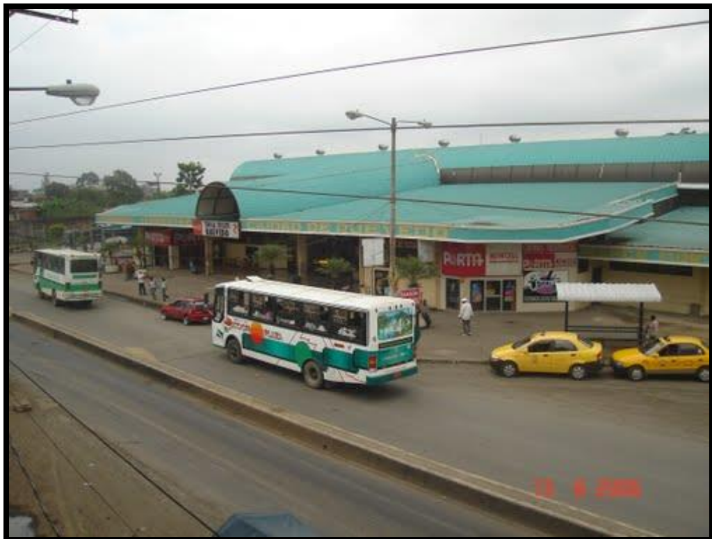
Figura 12 Terminal Terrestre de Quevedo
