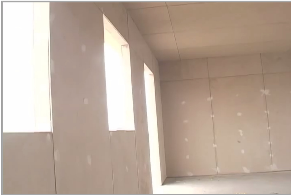
Ilustración No. 79 Acabado de interiores sistema drywall.
