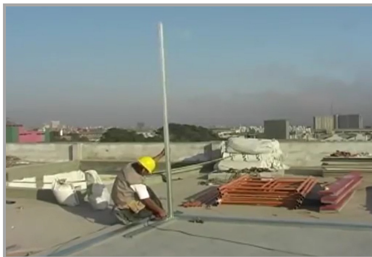
Ilustración No. 57 Construcción de perfilería de pared.
