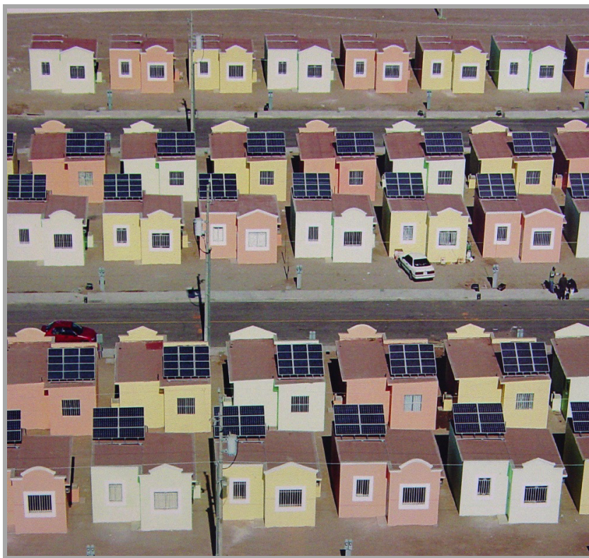
Ilustración No. 20 Vista aérea proyecto de vivienda social Hipoteca Verde en México.
