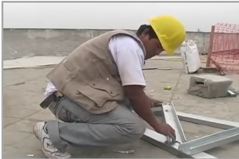
Ilustración No. 63 Construcción de cabreada.
