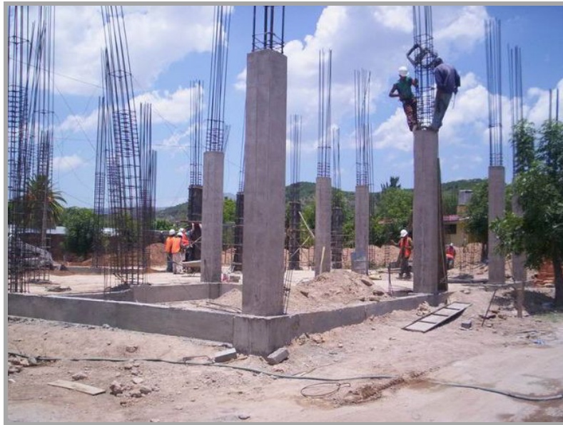
Ilustración No. 22 Columnas de Hormigón Armado.
