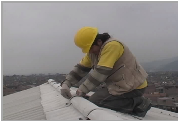
Ilustración No. 76 Instalación cumbre de fibrocemento en cubierta.
