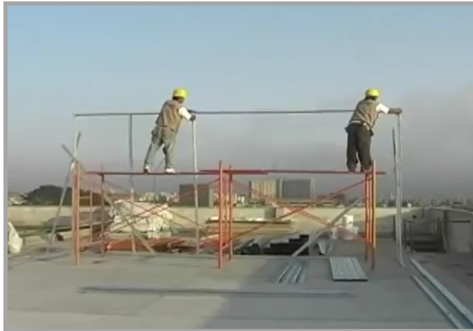
Fuente: Construcción sistema drywall Eternit (2016).
