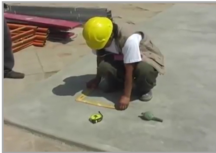
Ilustración No. 51 Losa de cimentación.
