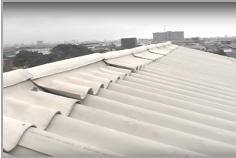
Ilustración No. 75 Instalación placa ondulada de fibrocemento en cubierta.
