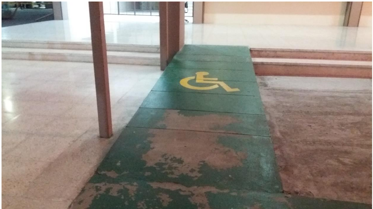
Figura 35 Rampa acceso 2 Recaudaciones “RP-13”
