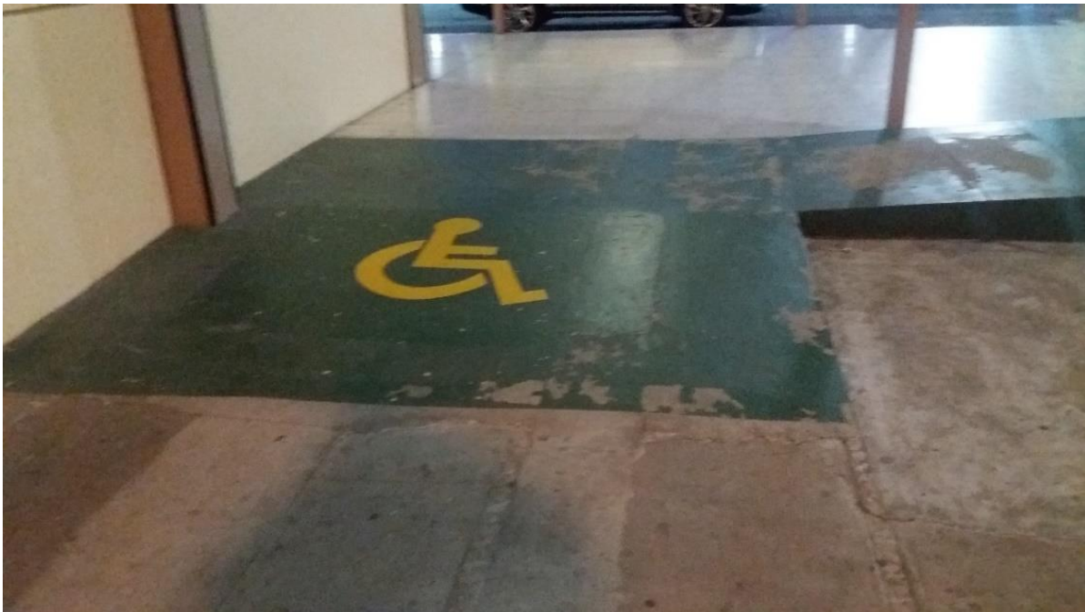
Figura 34 Rampa acceso 1 Recaudaciones “RP-12”
