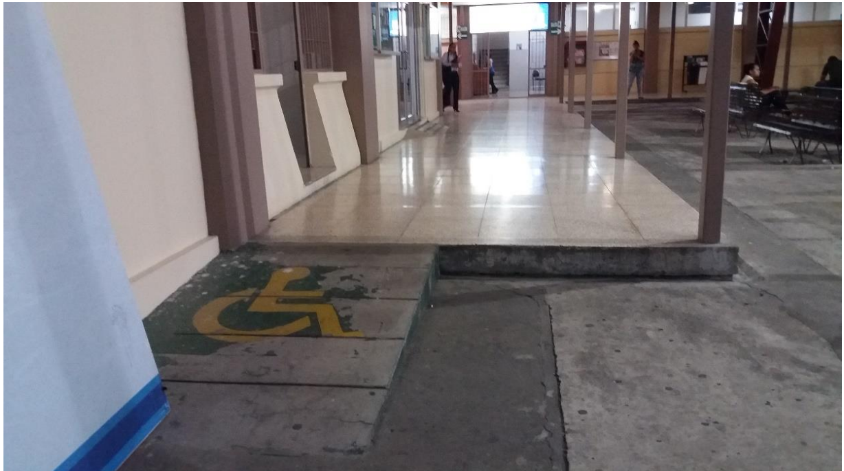
Figura 31 Rampa posterior Facultad de Administración Cancha Uso Múltiple “RP-9”
