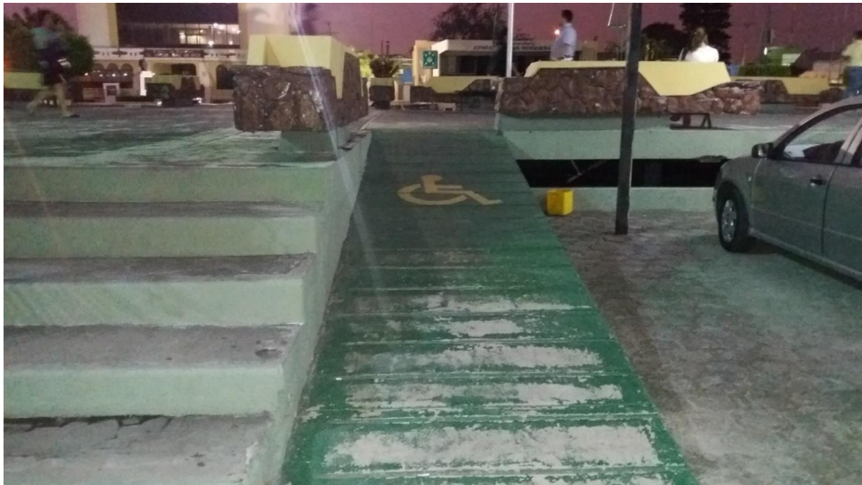
Figura 24 Rampa junto a Biblioteca “RP-2”
