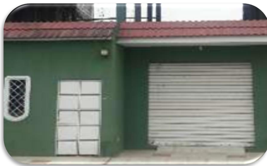
Figura 18 Vista Frente del espacio donde funcionará CONSULTCOM
