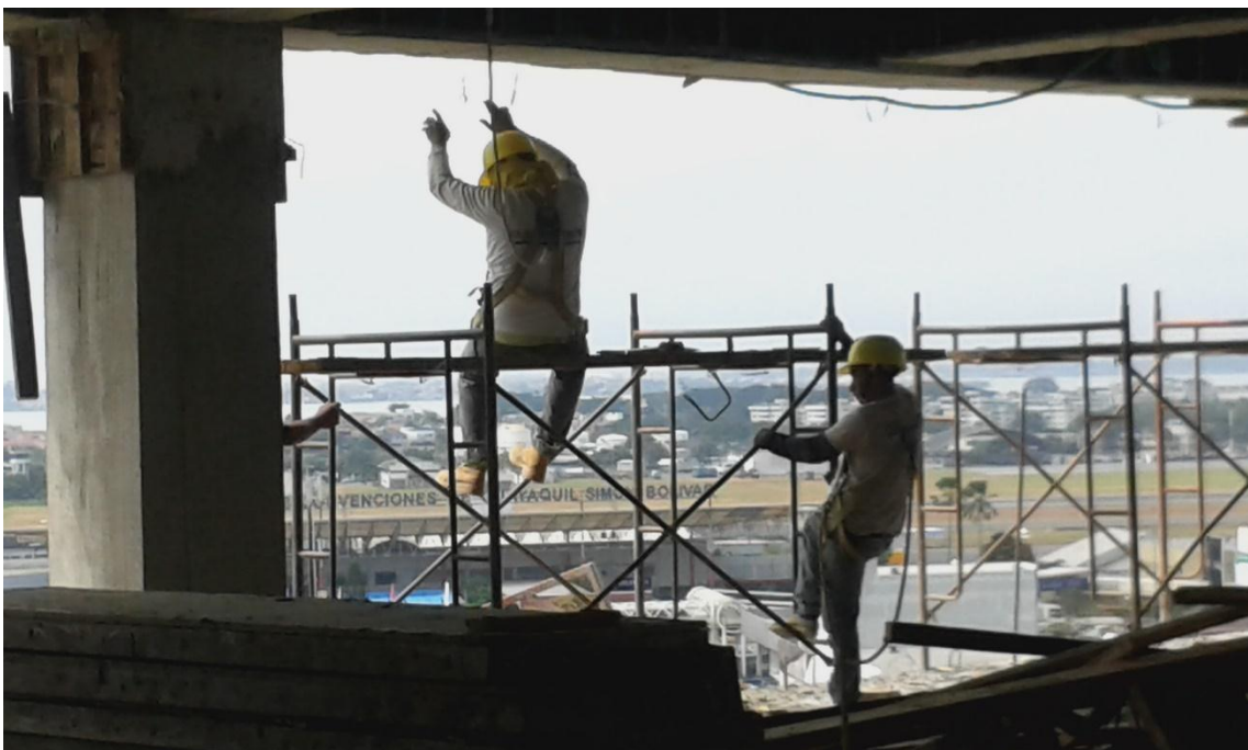
Foto No. 20. Trazado para pared Fuente: Edificio de 12 Pisos
