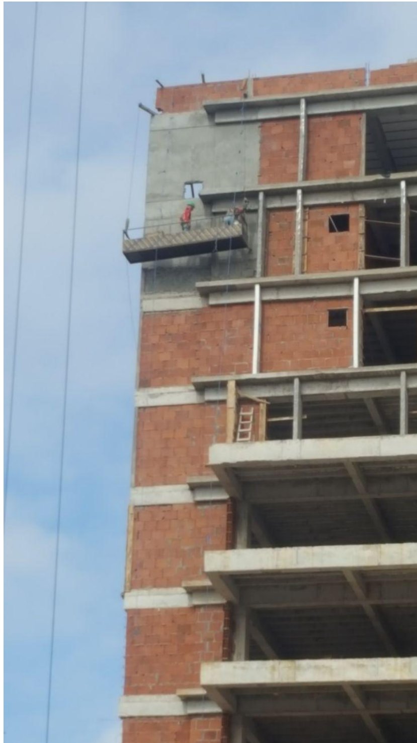
Foto No. 16. Enlucido de paredes exteriores
