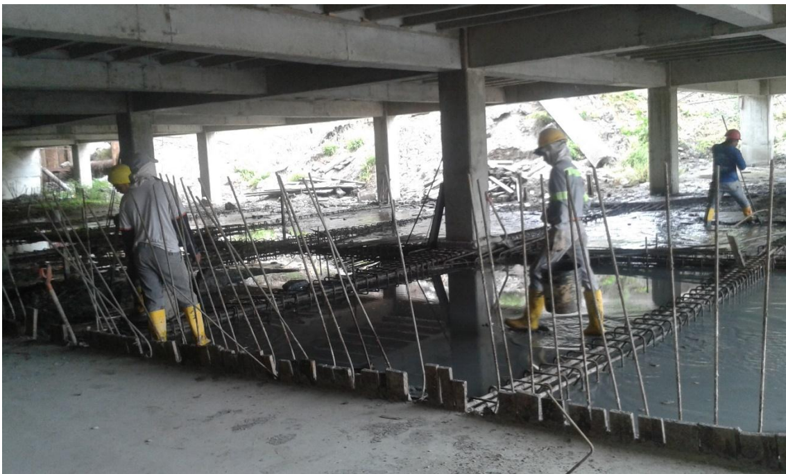
Foto No. 6. Limpieza de sótano Fuente: Edificio de 12 Pisos
