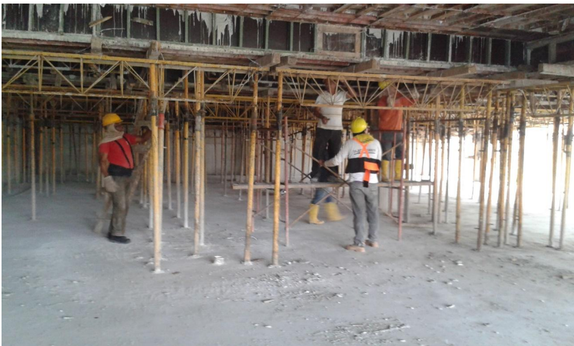
Foto No. 18. Desencofrado de losa
