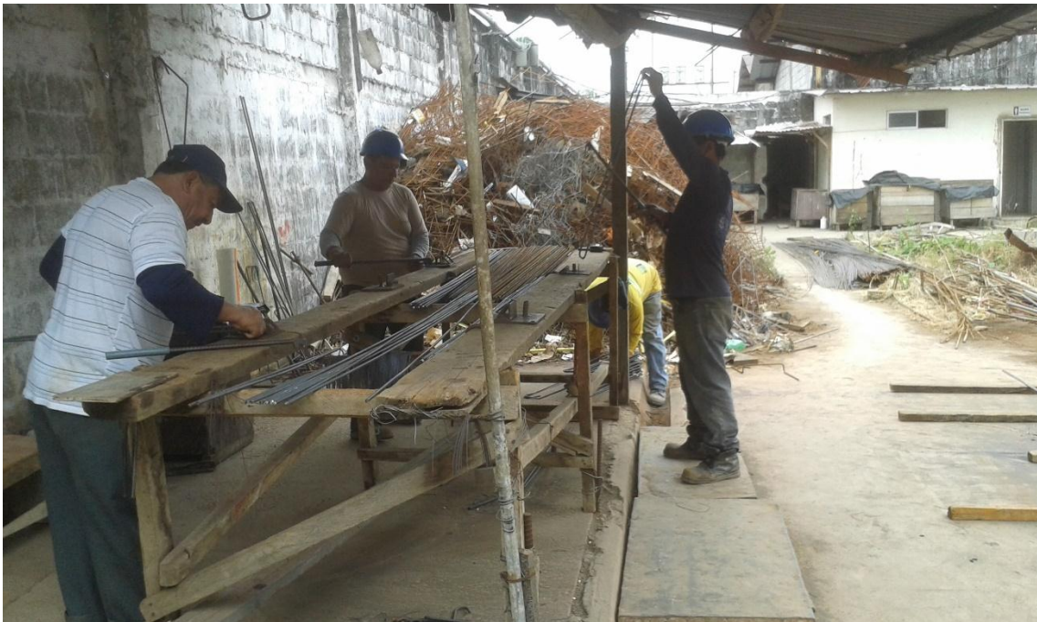
Foto No. 29. Carpintería metálica Fuente: Edificio de 12 Pisos
