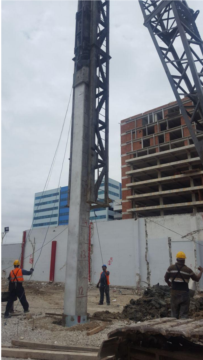
Foto No. 2. Hincado de pilotes
