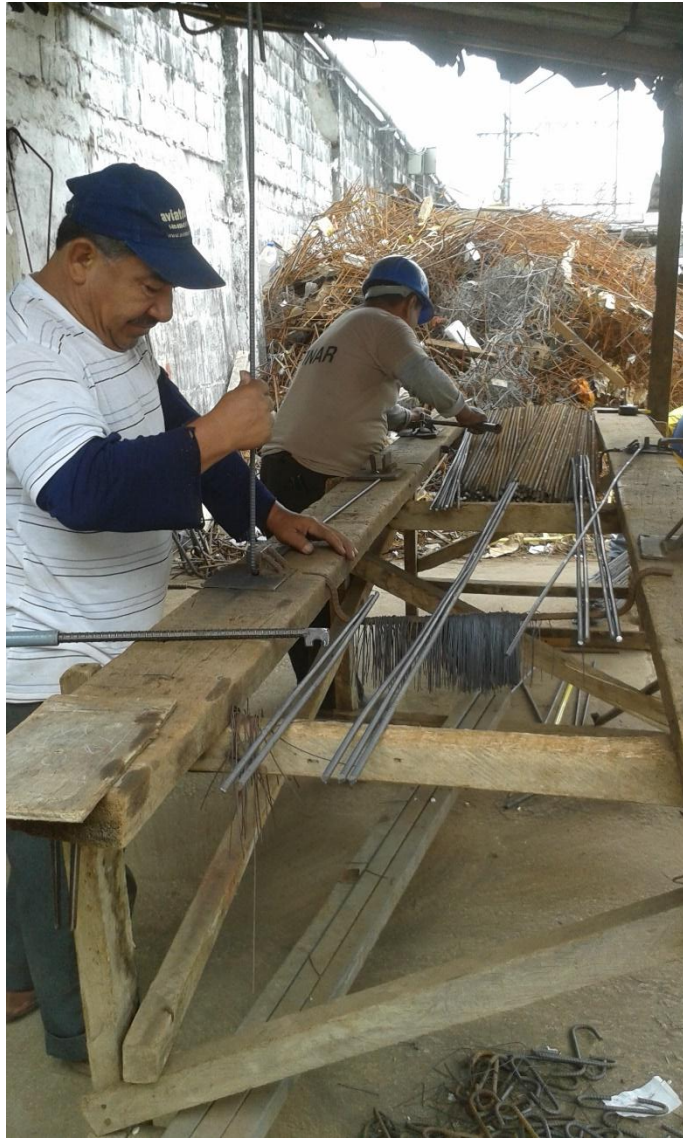
Foto No. 27. Figurado de acero
