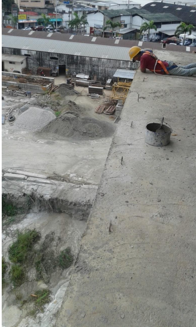
Foto No. 23. Limpieza de rebaba de losa Fuente: Edificio de 12 Pisos
