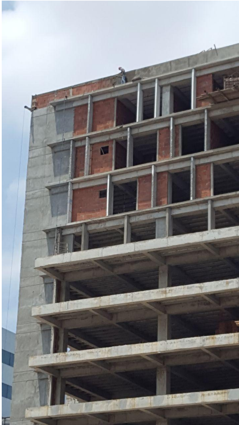
Foto No. 15. Enlucido de paredes exteriores Fuente: Edificio de 12 Pisos
