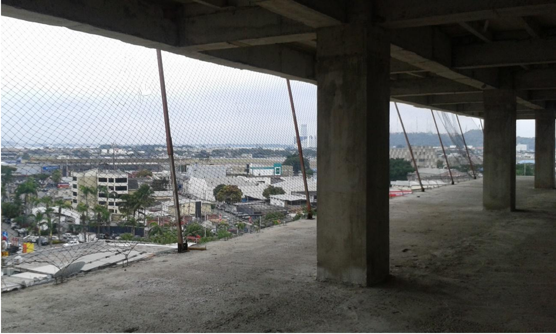
Foto No. 11. Protección colectiva (enmallado) Fuente: Edificio de 12 Pisos
