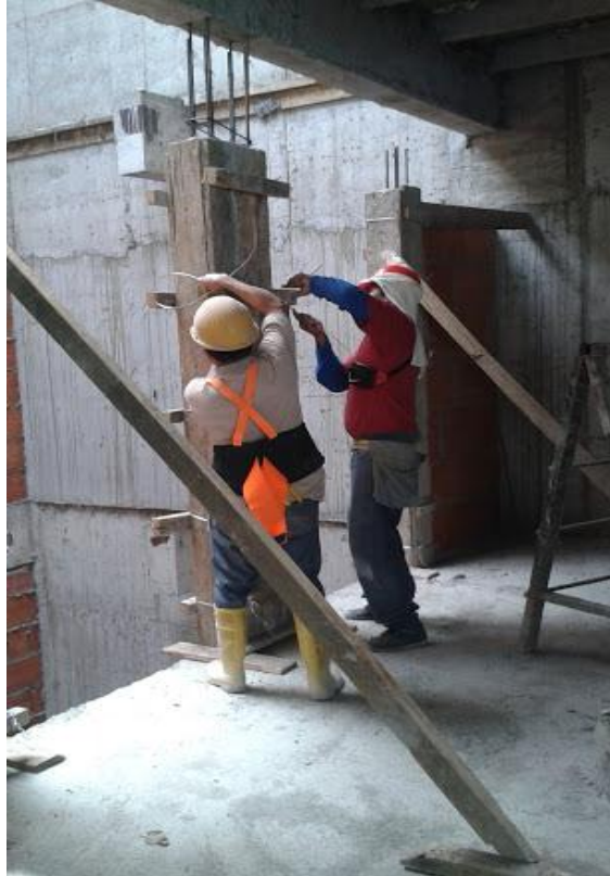
Foto No. 3. Encofrado de pilarete
