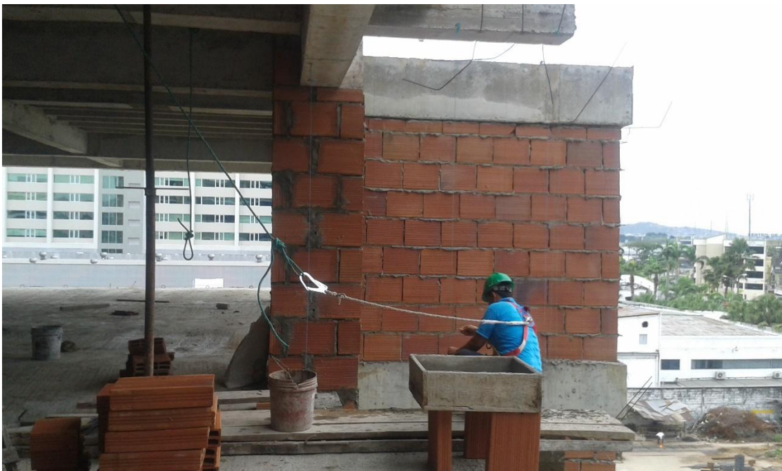
Foto No. 4. Uso de arnés de seguridad
