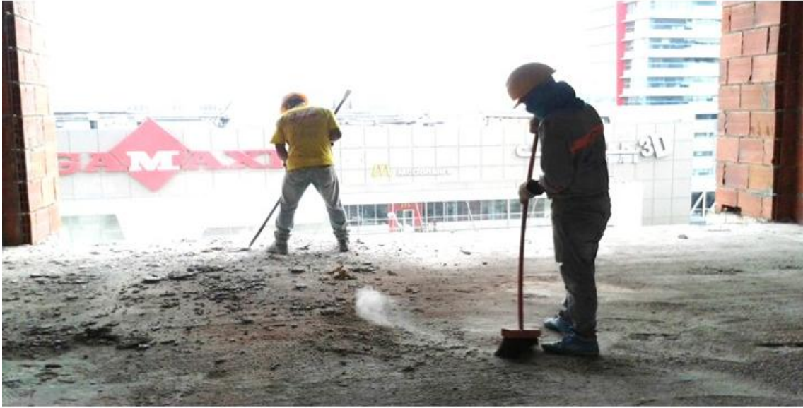
Foto No. 28. Limpieza de rebaba Fuente: Edificio de 12 Pisos
