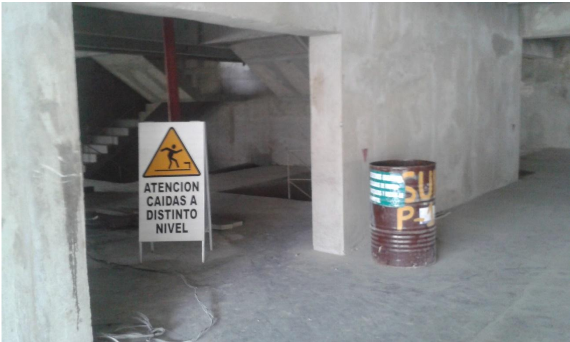
Foto No. 26. Señalización vertical
