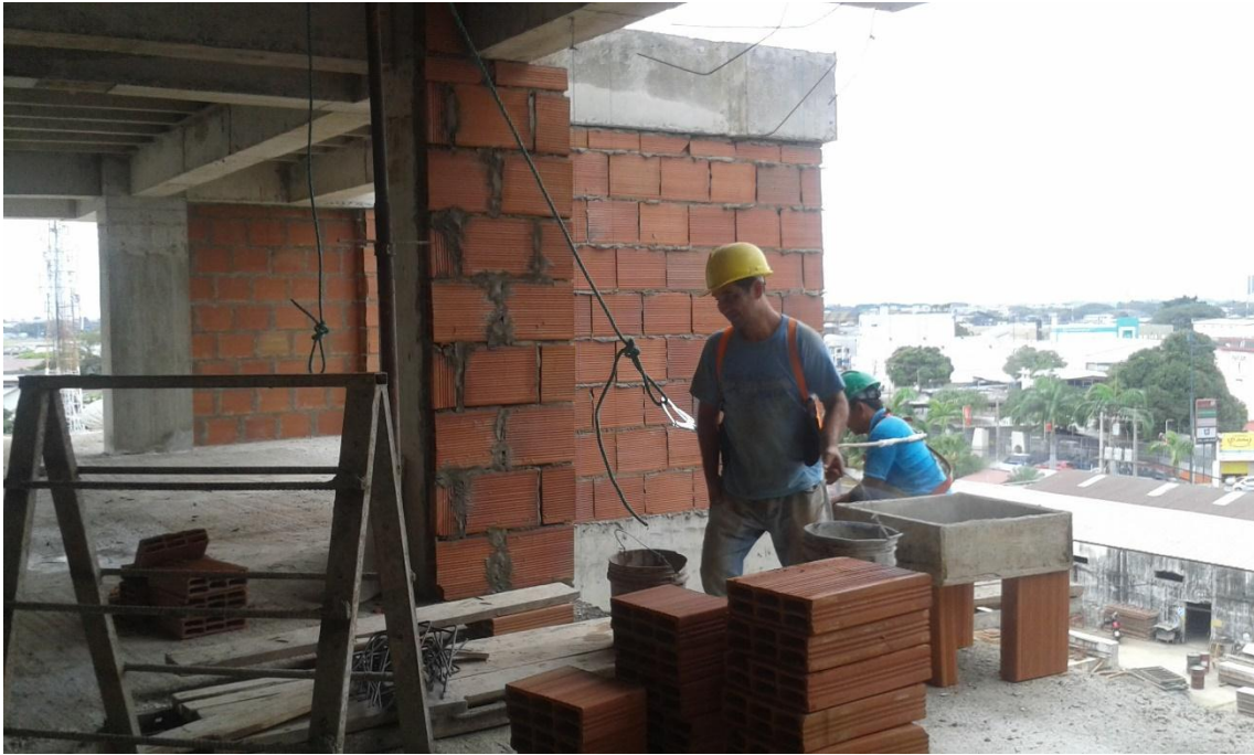
Foto No. 25. Emblocado de pared
