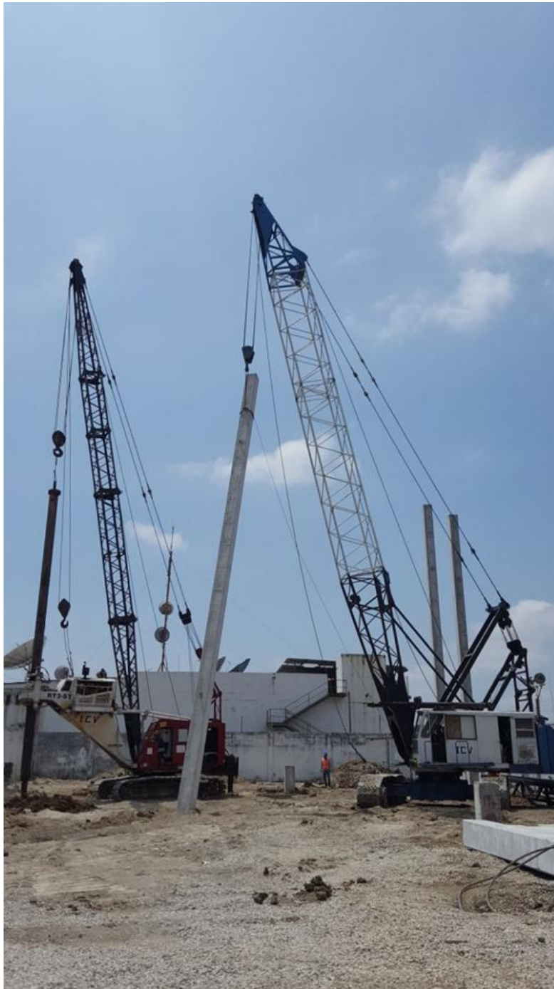
Foto No. 1. Hincado de pilotes
