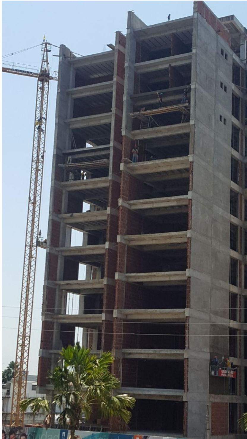
Foto No. 14. Enlucido de paredes exteriores Fuente: Edificio de 12 Pisos
