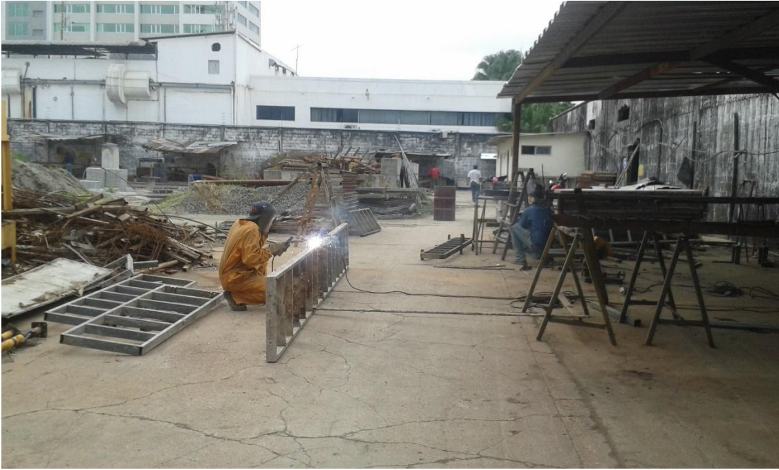
Foto No. 5. Proceso de soldadura Fuente: Edificio de 12 Pisos
