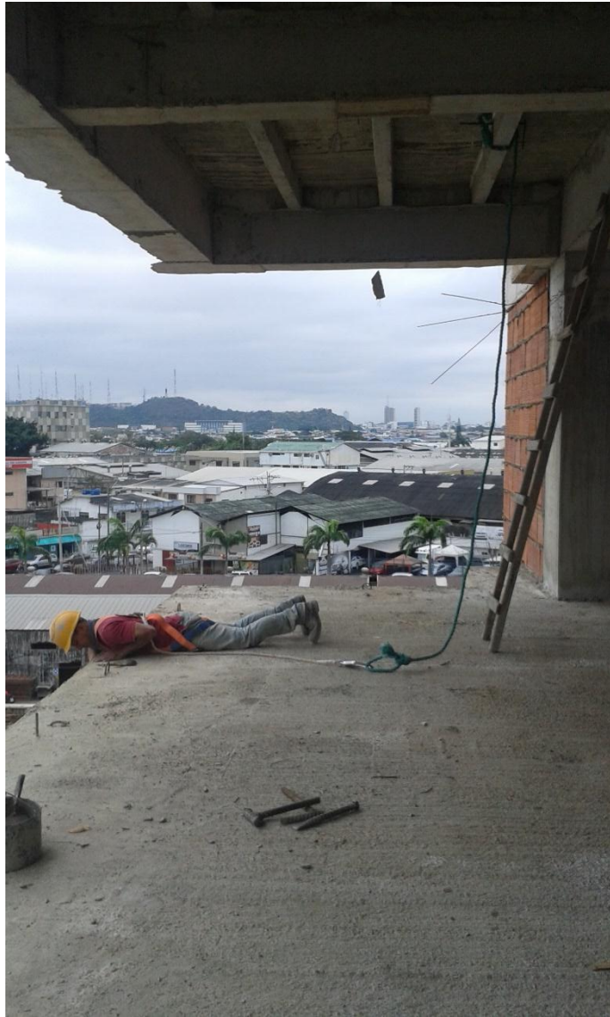
Foto No. 24. Limpieza de rebaba de losa Fuente: Edificio de 12 Pisos
