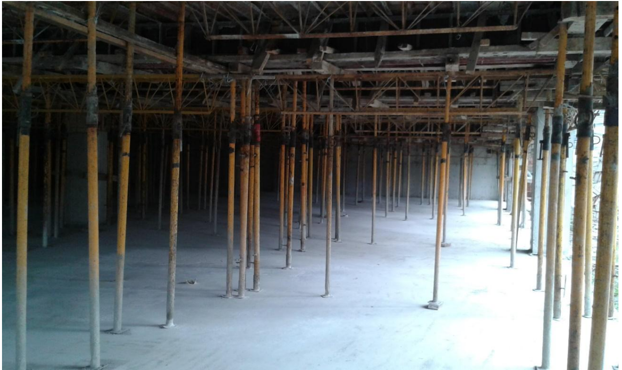
Foto No. 21. Encofrado de losa
