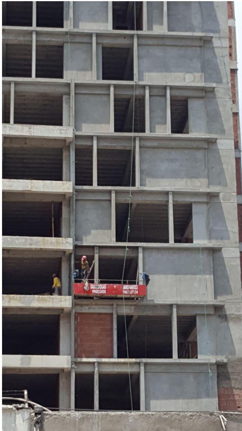
Foto No. 13. Enlucido de paredes exteriores Fuente: Edificio de 12 Pisos
