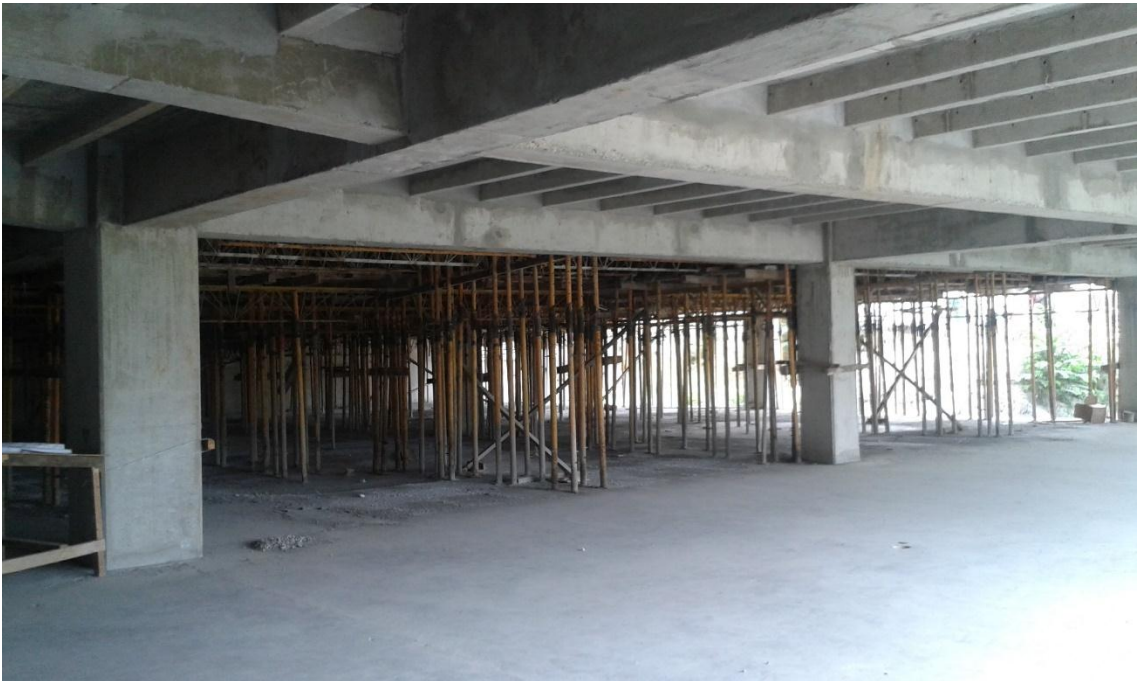
Foto No. 12. Encofrado de losa Fuente: Edificio de 12 Pisos
