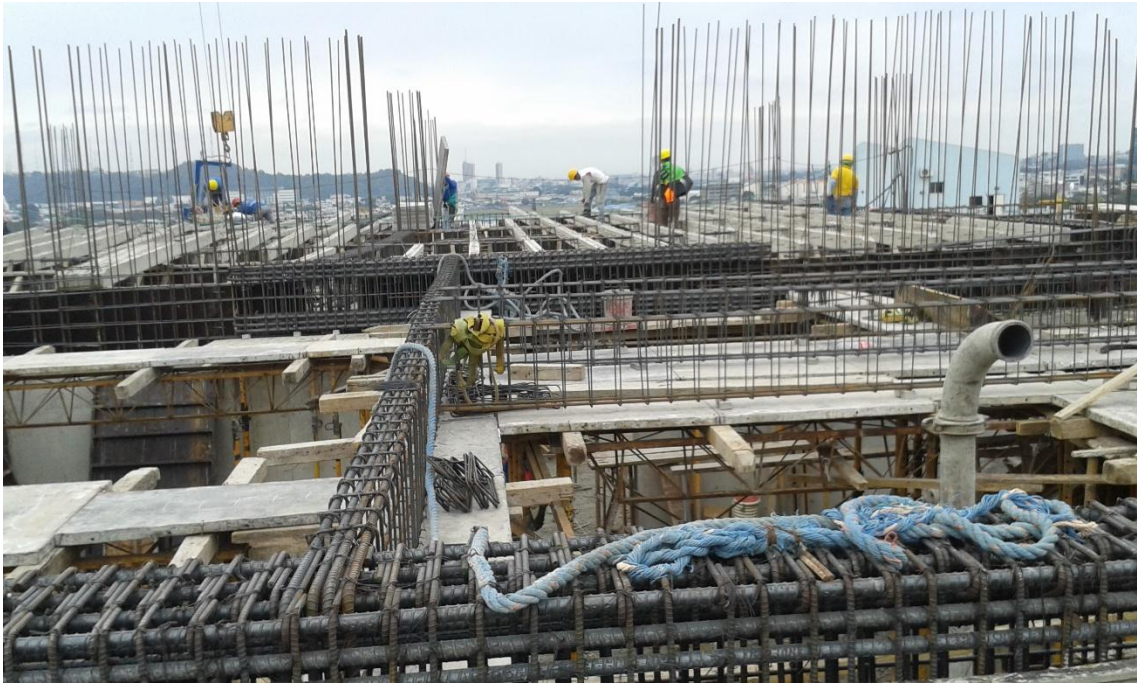
Foto No. 19. Armado de losa Fuente: Edificio de 12 Pisos
