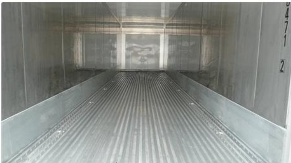
Figura 24 Vista del interior de los contenedores Reefer de 40'
