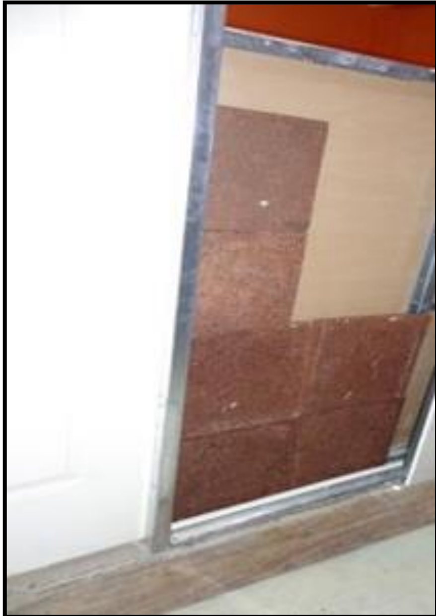
Ilustración 74: Panel en instalación.
