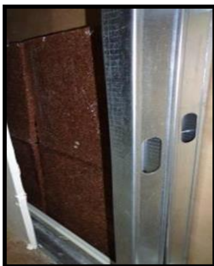
Ilustración 73: Panel en proceso de instalación
