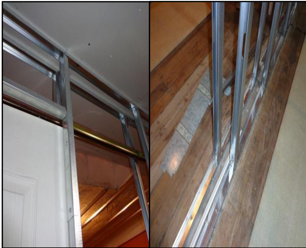
Ilustración 68: Proceso de elaboración de una pared divisoria
