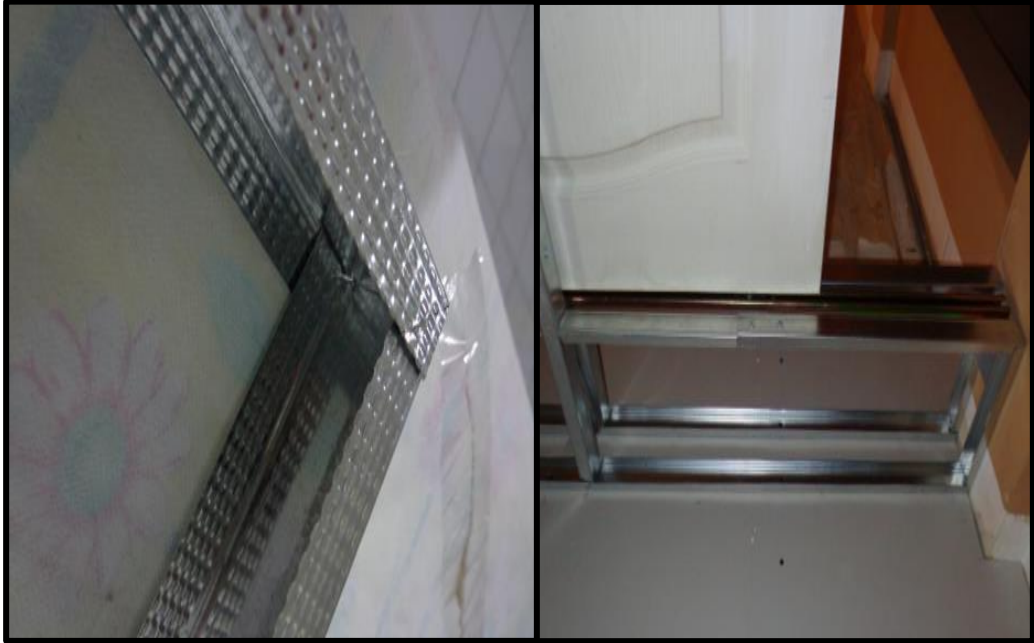
Ilustración 69: Conformación de la estructura metálica.
