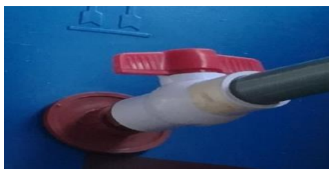
Ilustración 3: Llave de paso de 1 pulgada de PVC Elaborado por: Ramos Medina W. (2018).
