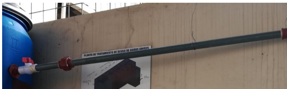
Ilustración 4: Tubos y unión universal de 1 pulgada Elaborado por: Ramos Medina W. (2018).
