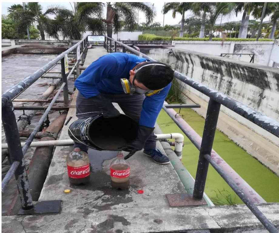
Ilustración 24: Envasado de agua residual de tanque de aireación Elaborado por: Ramos Medina W. (2018)
