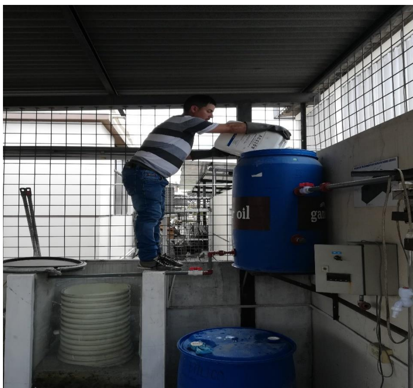
Ilustración 26: Vertido del agua residual doméstica a la planta piloto Elaborado por: Ramos Medina W. (2018)
