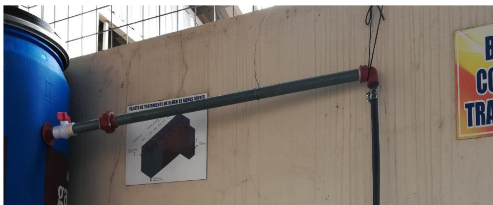
Ilustración 5: Codo reductor de 1 pulgada a \frac{3}{4} " Elaborado por: Ramos Medina W. (2018)
