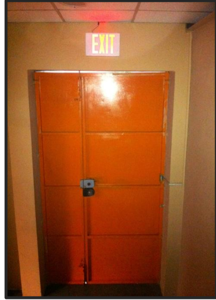
Foto 17: Salida de emergencia
