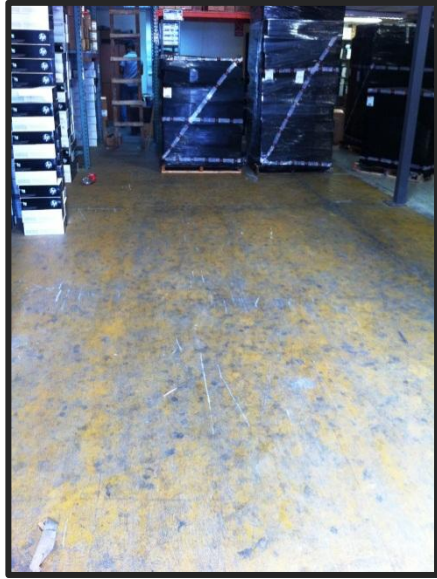
Foto 24: Área de descarga (1)
