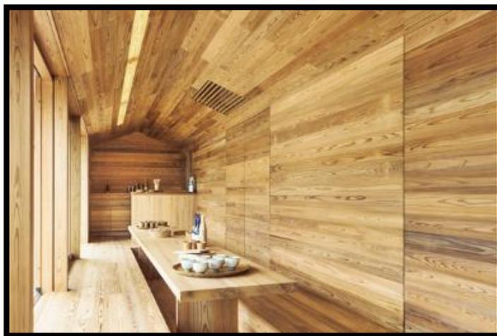
*Imagen 15. Paneles para revestimiento de madera*
