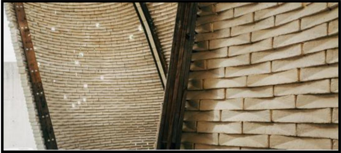
*Imagen 8.*Panel para fachadas con materiales biocompuestos
