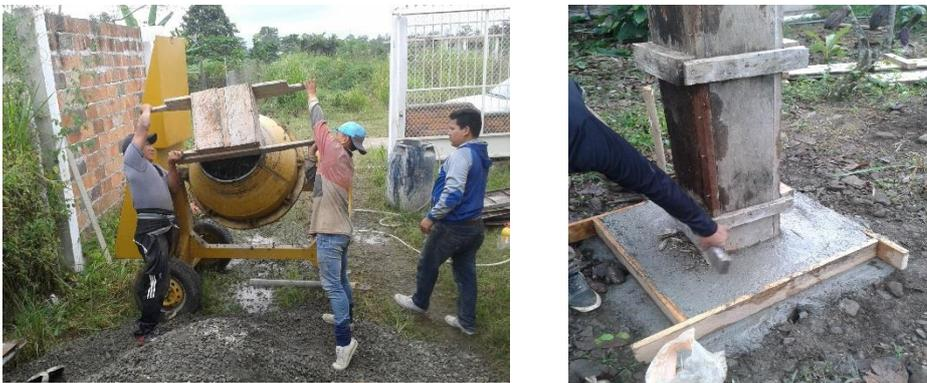
Figura 16. Fundición de plintos
