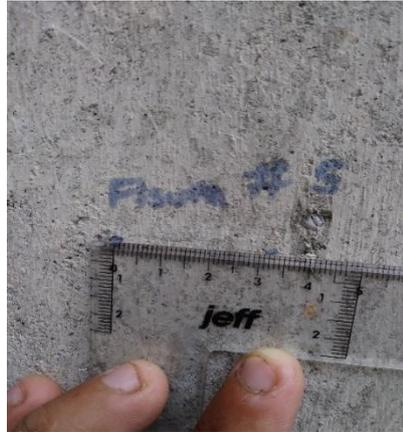
Figura 67. Medición de la longitud de la fisura # 5 = 3,15 cm
