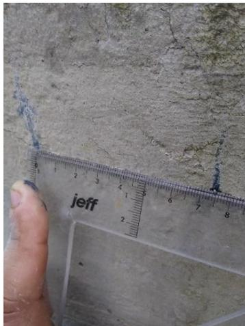
Figura 92. Medición de longitud de fisura # 1 = 7,50 cm
