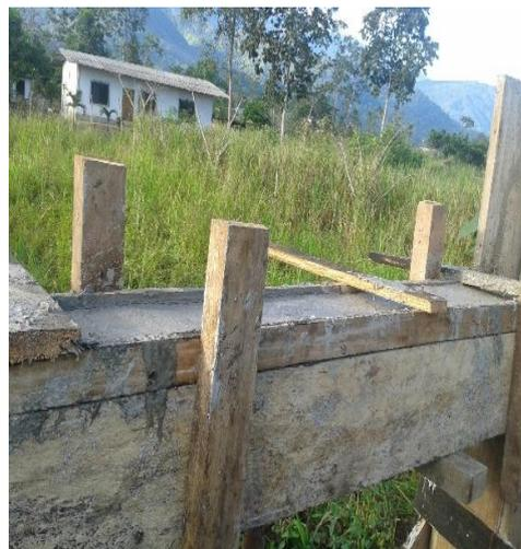
Figura 24. Desencofrado de los encofrados laterales
