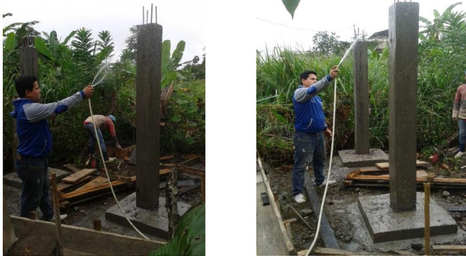
Figura 25. Curado de columnas
