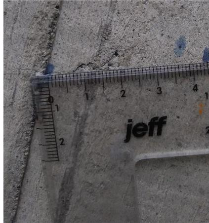
Figura 79. Medición de la longitud de la fisura #5 = 4,35 cm
