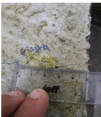
Figura 82. Medición de la longitud de fisura #4= 2,95 cm
