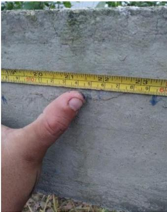
Figura 89. Medición de longitud de fisura # 9 = 59,50 cm
