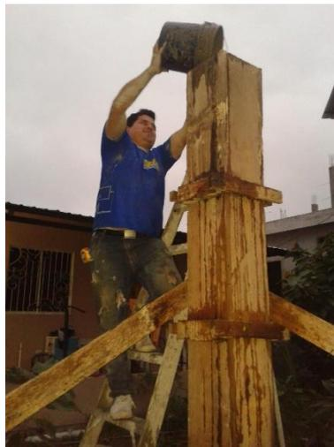
Figura 18. Fundición de pilares
