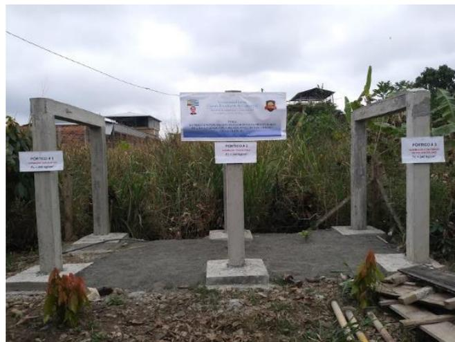
Figura 26. Desencofrado de vigas de pórticos a 28 días
