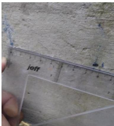
Figura 95. Medición de la longitud de fisura # 1 = 7,95 cm
