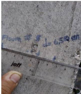
Figura 85. Medición de la longitud de fisura # 5= 6,50 cm
