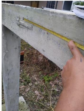
Figura 71. Medición de longitud de fisura # 9 = 39,40 cm
