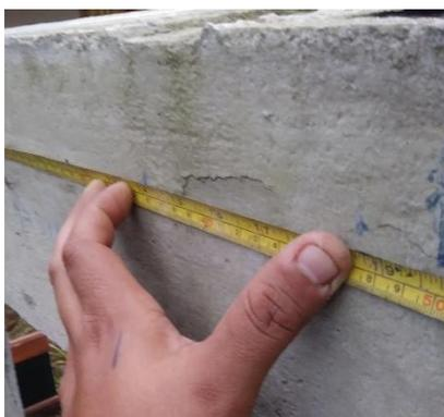
Figura 62. Medición de la longitud de fisura #4 = 50,00 cm
