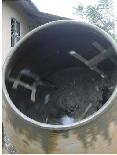
Figura 19. Colocación de aditivos de fibras de polipropileno
