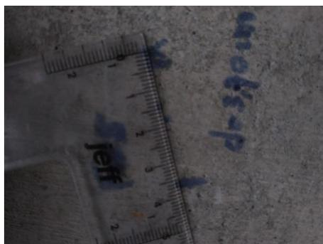
Figura 61. Medición de la longitud de la fisura # 5= 3,70 cm
