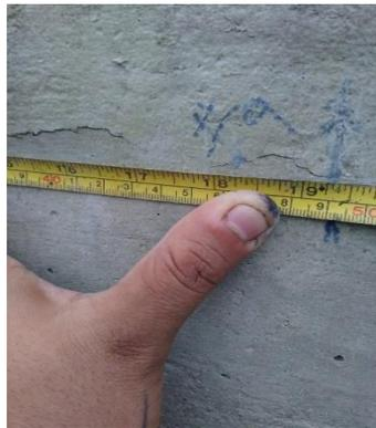
Figura 77. Medición de longitud de fisura # 9= 49,25 cm
