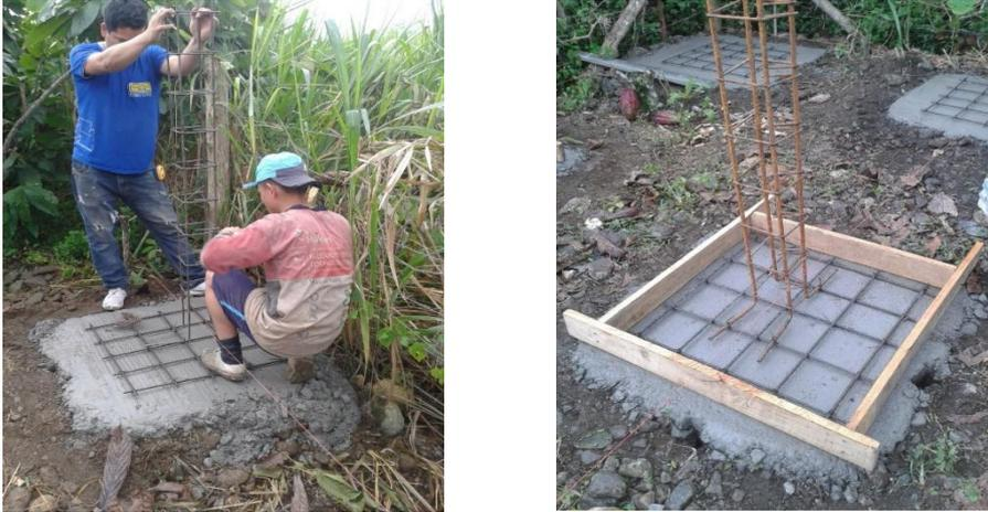
Figura 15. Colocación de parrillas de plintos
