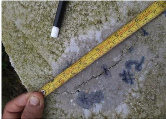
Figura 86. Medición de la longitud de fisura # 2 = 17,90 cm
