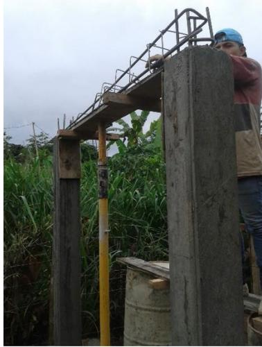
Figura 23. Desencofrado de vigas
