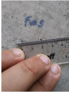
Figura 43. Medición del largo de la fisura # 5=2,10 cm
