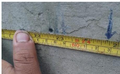
Figura 47. Medición de la longitud de la fisura #7 = 62,80 cm
