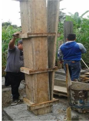
Figura 17. Colocación de encofrados
