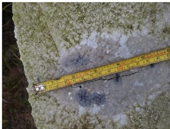
Figura 74. Medición de la longitud de fisura # 2= 13,20 cm
