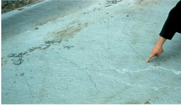
Figura 3. Fisuras causadas por retracción plástica
