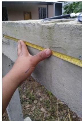
Figura 50. Medición de la longitud de fisura # 4= 47,60 cm
