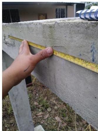
Figura 56. Medición de la longitud de fisura # 4= 49,70 cm
