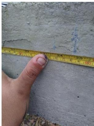
Figura 53. Medición de la longitud de fisura # 7= 88,15 cm
