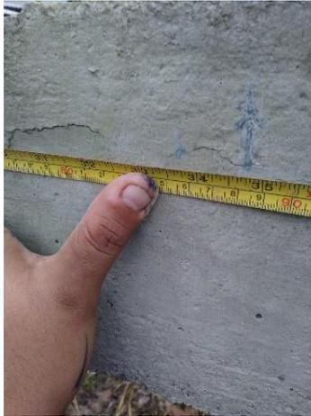
Figura 59. Medición de la longitud de fisura #7= 88,15 cm
