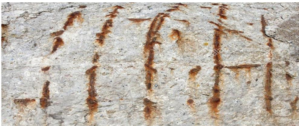
Figura 2 Hormigón con manchas de óxido.
