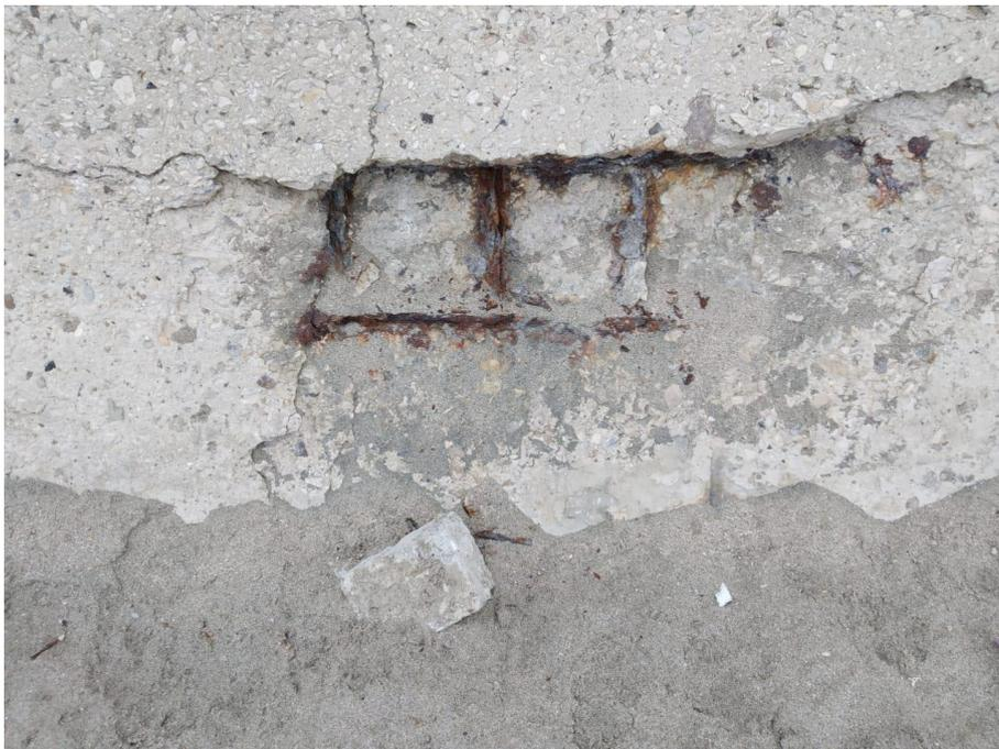
Figura 37. .Acero de refuerzo Corroído.
