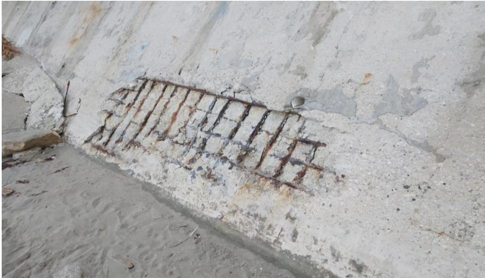
Figura 5 Armadura corroída de muro de contención.
