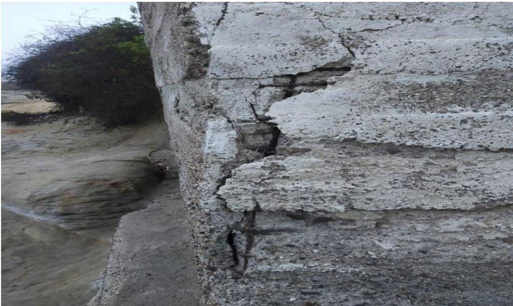
Figura 4 Desprendimiento de hormigón.
