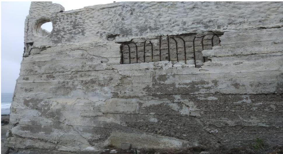
Figura 6 Acero de refuerzo expuesto.
