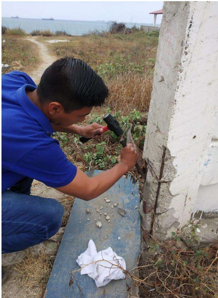
Figura 7. Muestra para ensayo de desgaste de sulfatos.
