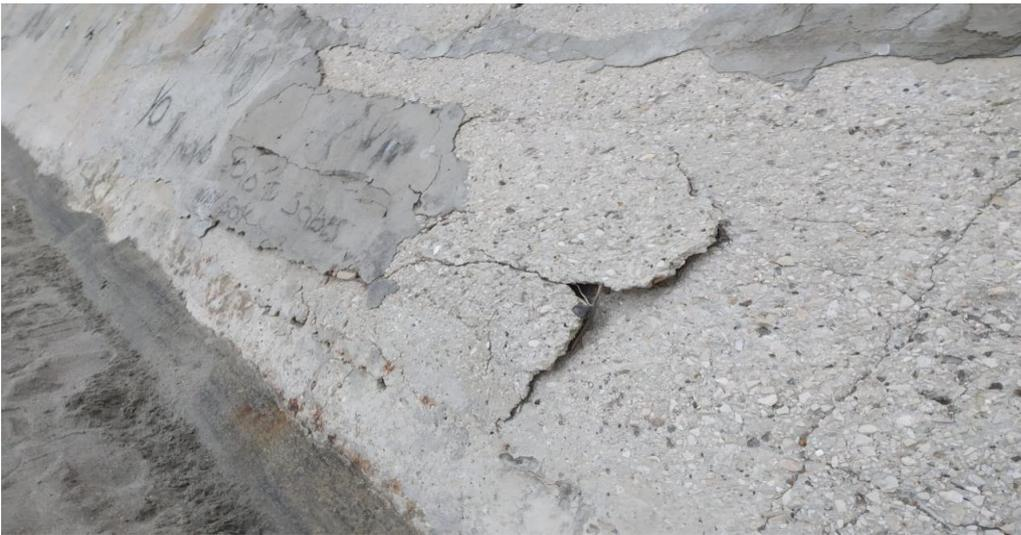
Figura 3 Agrietamiento de hormigón.
