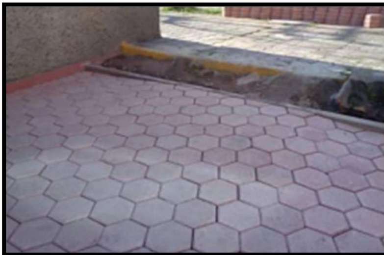
Figura 18. Aplicación de adoquines fabricados Fuente: Zavala, 2015
