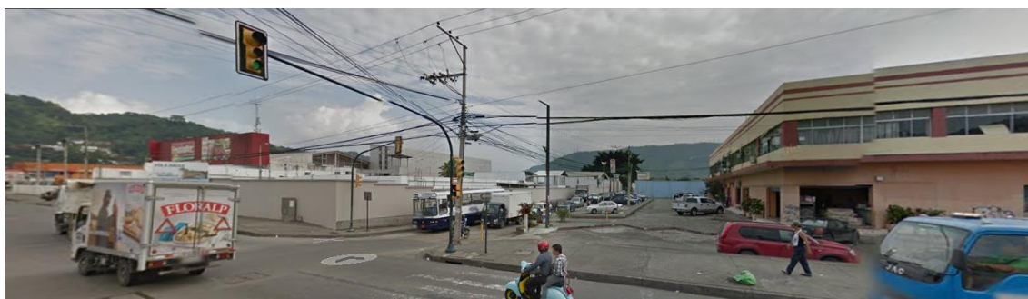
Figura 16 Imagen frontal del Local Comercial Fuente: Google Maps, (2019)
