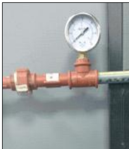
Ilustración 25: Tramo de Tubería.
