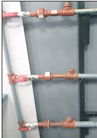
Ilustración 24: Tramo de Tubería.
