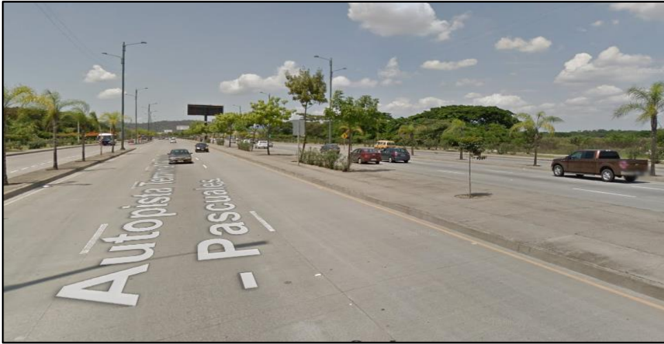
Figura 25: Vista panorámica de la Autopista Terminal Terrestre – Pascuales.
