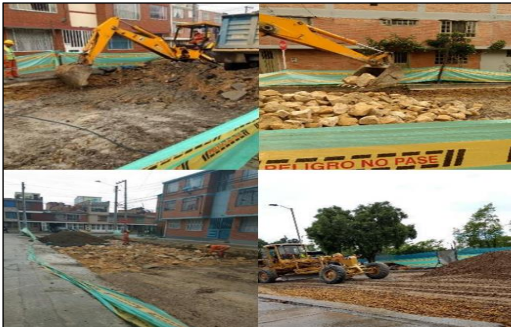
Figura 63: Excavación, mejoramiento de sub-rasante, sub-base y base granular. Fuente: repository.udistrital.edu.com.
