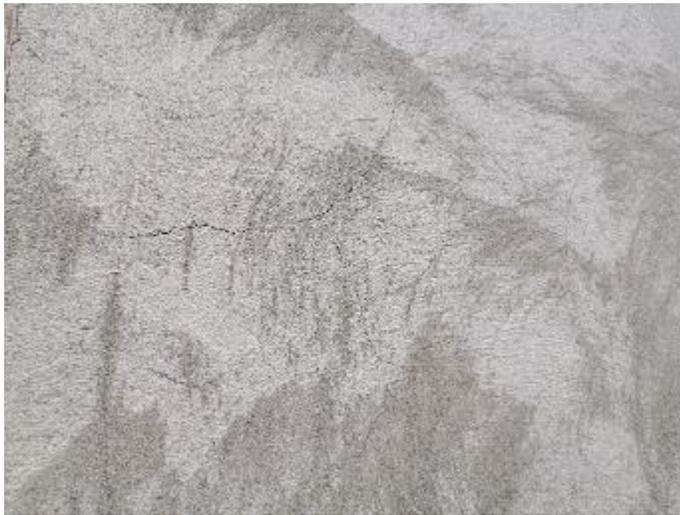
**Gráfico 35** Fisuras presentadas por retracción hidráulica.
