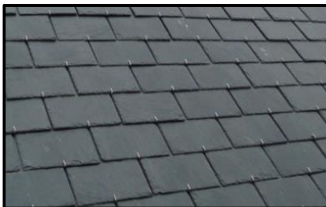
Cubierta de pizarra
