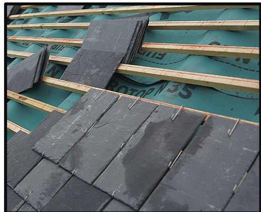
Figura 24: Cubierta de placa de pizarra.
