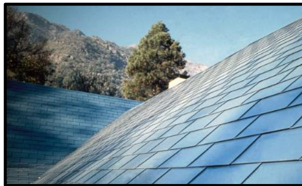
Figura 33: Cubierta de teja de metal. Fuente: Enciclopedia de clasificaciones (2017)
