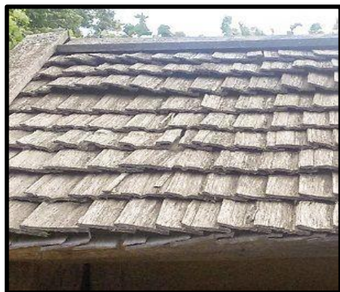
Figura 31: Chillados. Fuente: Google (2019)
