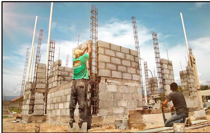
Figura 89: Proceso de construcción de una vivienda.
