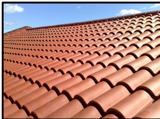
Figura 28: Cubierta de Teja. Fuente: Google (2019)
