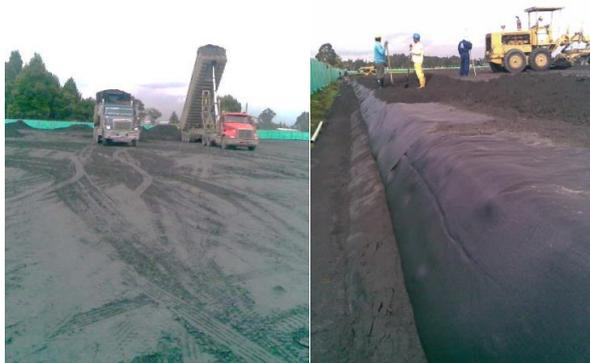
**Figura 10.** Relleno con Ceniza Volante.
