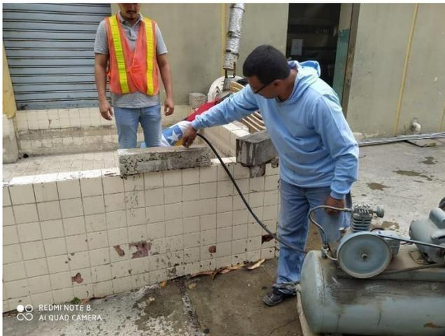
**Foto 10:** Limpieza con granallado en viga con desgaste.
