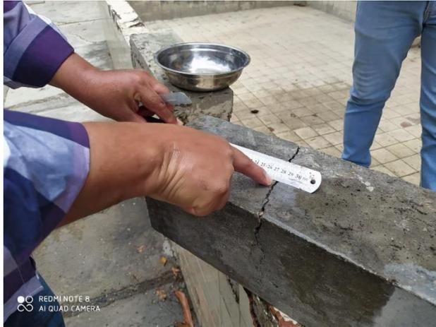
**Foto 7:** fisura en viga.
