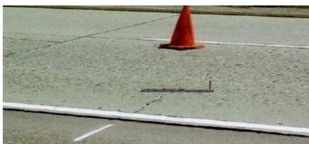
*Figura 17: Descaramiento*
