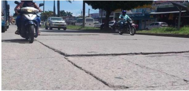
**Figura 15: Desnivel de losa**
