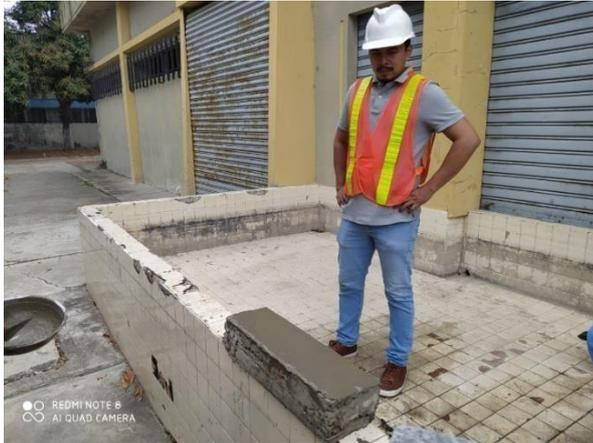
**Foto 12:** Colocación del mortero en viga con desgaste.
