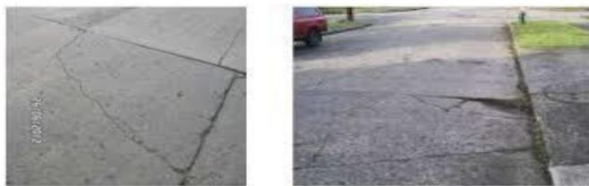
**Figura 10: Fisura de esquina**
