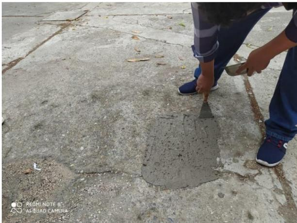
**Foto 13:** Colocación del mortero en pavimento con desgaste y fisura.
