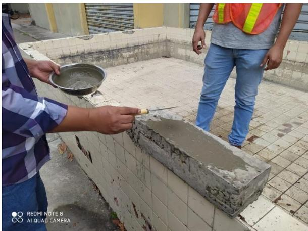
**Foto 11:** Colocación del mortero en viga con desgaste.
