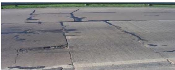
*Figura 11: Losa dividida*
