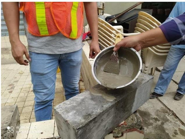
**Foto 8:** Colocación del mortero en fisura.
