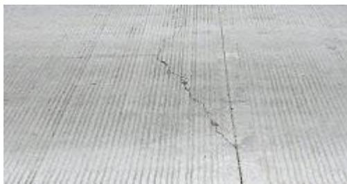
**Figura 12: Fisura en bloque**
