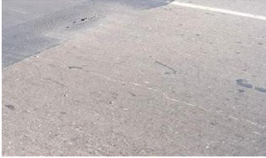
**Figura 9: Fisura longitudinal**
