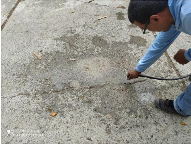
**Foto 9:** Limpieza con granallado en fisura y desgaste de pavimento.
