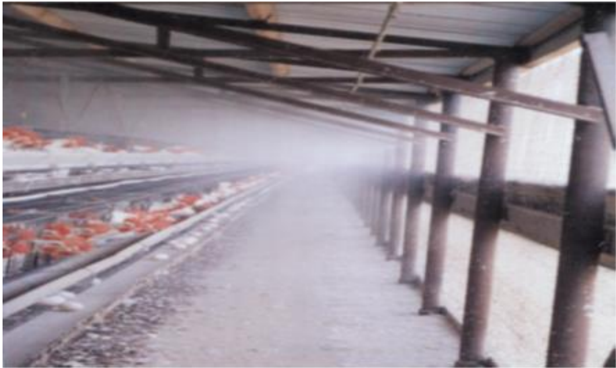
Figura 32. Sistema de humidificación Elaborado por: Muñoz, (2021)
