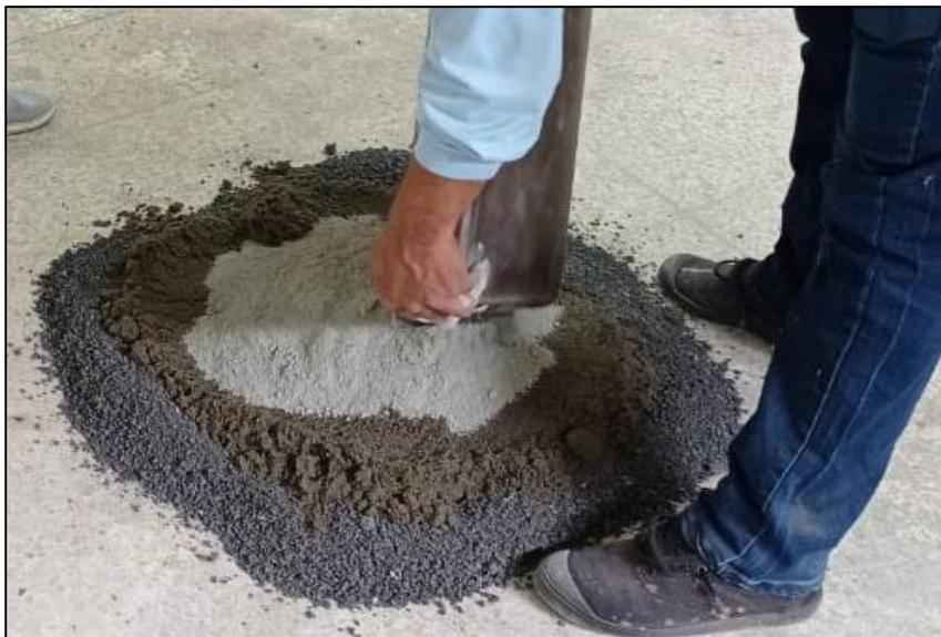
Figura 3. Dosificación del cemento, arena y toba volcánica
