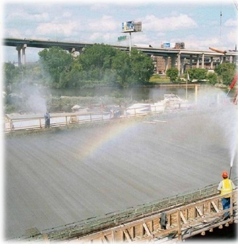
**Figura 2.** Curado de losa de hormigón
