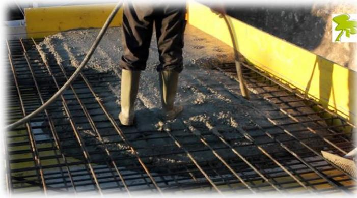
**Figura 12.** Losa de hormigón armado
