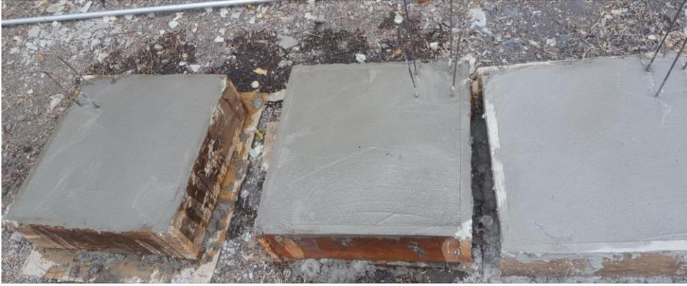
**Figura 67.** Segmentos de losa humedecidos
