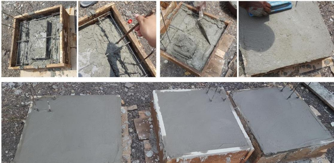
**Figura 47.** Fundición y acabado de segmentos de losa
