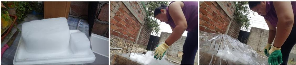
**Figura 68.** Segmentos de hormigón al primer día tras fundición
