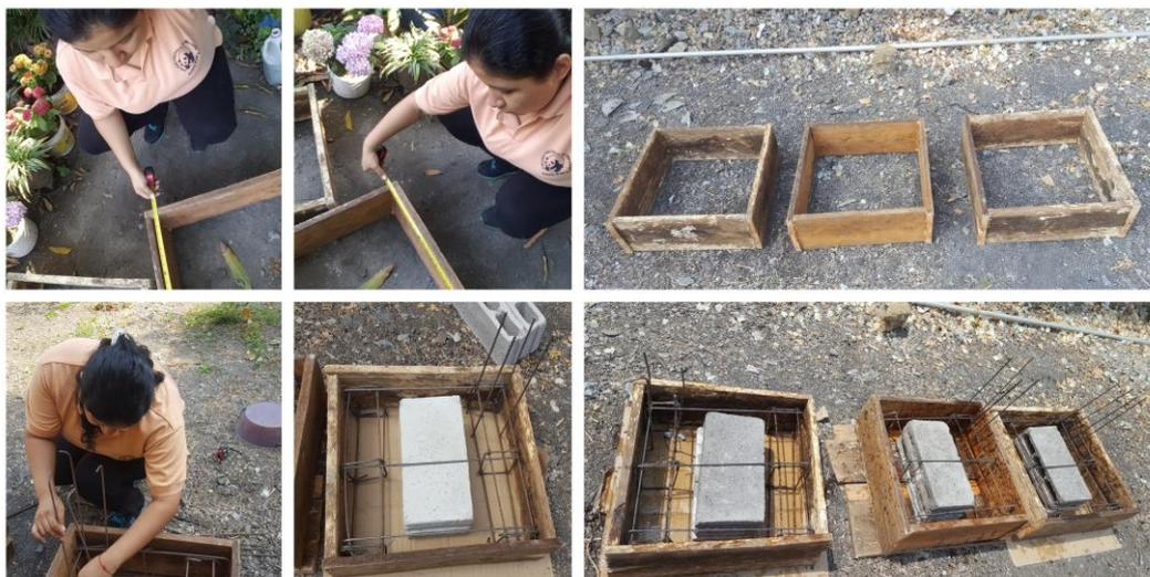
**Figura 40.** Preparación de moldes para segmentos de losas
