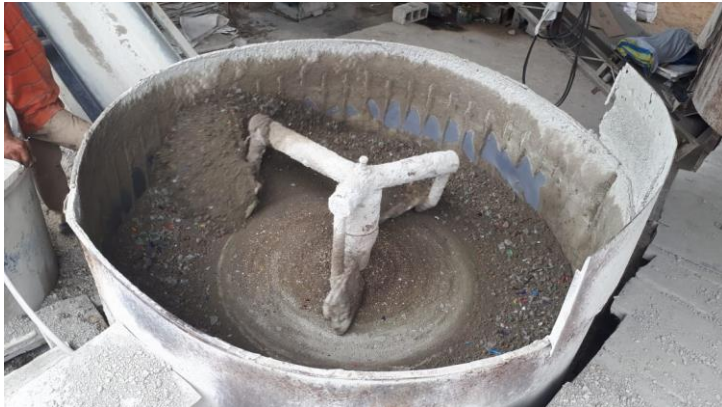
Figura 33: Proceso de mezclado de los materiales
