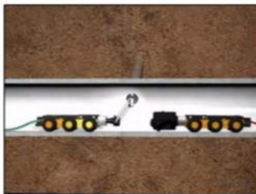
**Imagen 25.** Reapertura de conexiones usando robot fresador
