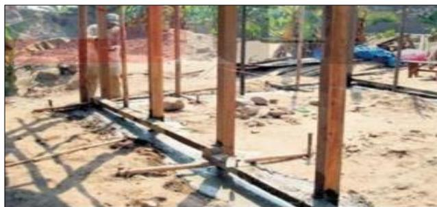
**Figura 45** Alineamiento de columnas de madera
