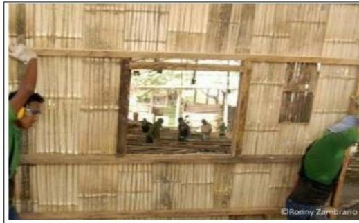
**Figura 19** Materiales ligeros y estructura flexible
