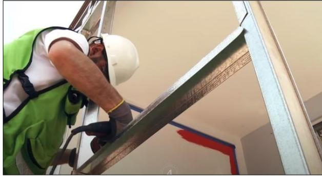
**Figura 54** Colocación de Montantes en las paredes Obra Sotonovo
