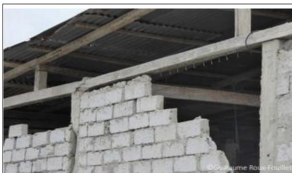
**Figura 15** Anclaje de muros de albañilería con estructura de madera
