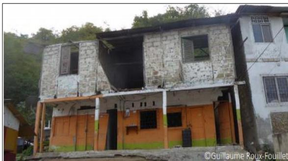
**Figura 14** Problemas de estabilidad frente al sismo de los muros de albañilería sustituto de la caña picada en vivienda de madera
