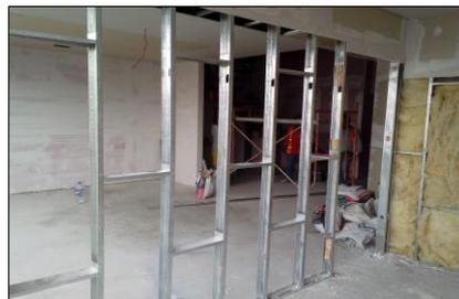
**Figura 106** Entramado de sistema drywall EdificioSantanaLoft
