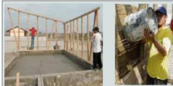
**Figura 41** Colocación de paredes de bahareque
