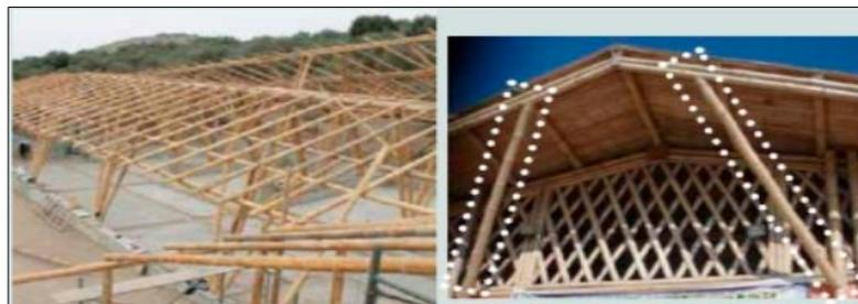
**Figura 42** Colocación Soportes en los aleros reforzados con correas
