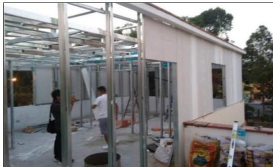
**Figura 55** Colocación de paneles de gypsum para exterior
