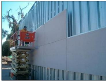
**Figura 33** Colocación de las planchas de Fibrocemento
