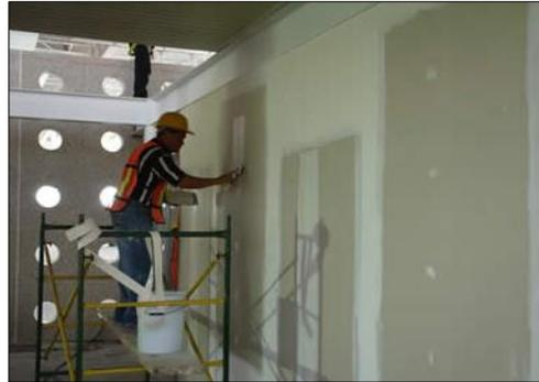
**Figura 56** Masillado de juntas para paredes en el edificio Santanaloft
