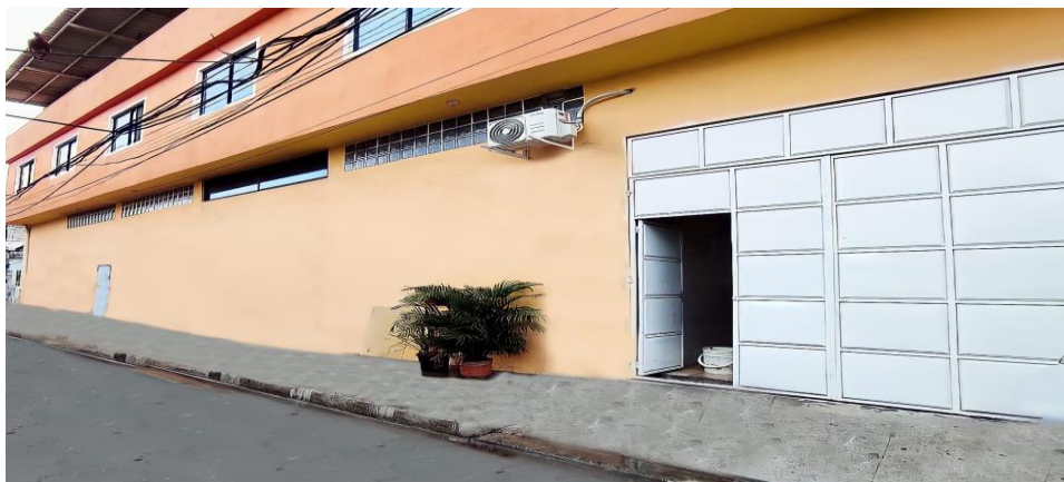
Figura 42 Instalaciones a utilizar
