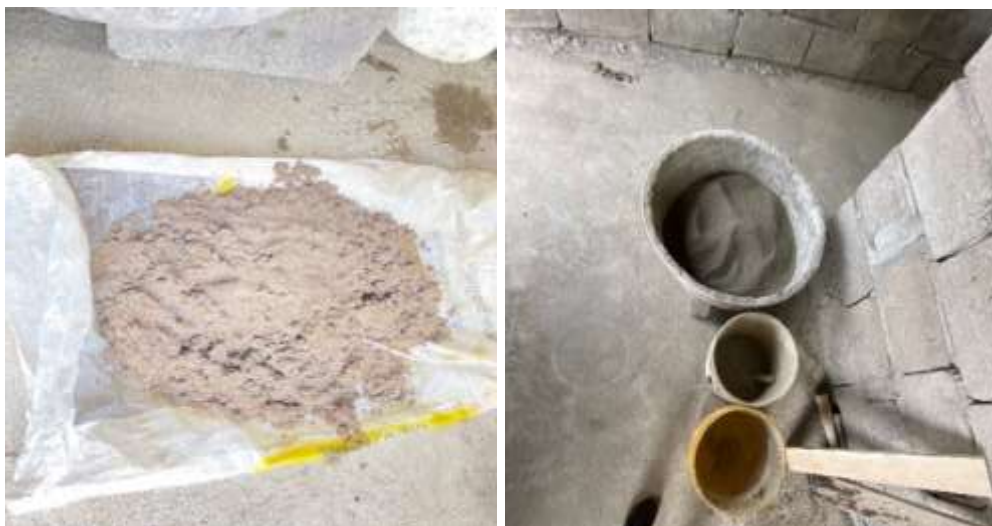
Figura 37. Materiales utilizados en la elaboración de mortero, derecha lodo efluente de la PTAP Daule Elaborado por: (Granoble Garcia & Tarira Santander, 2020)
