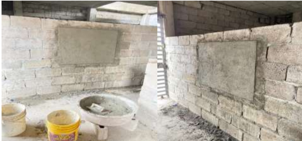
Figura 40. Pared enlucida con lodo proveniente de la PTAP Elaborado por: (Granoble Garcia & Tarira Santander, 2020)
