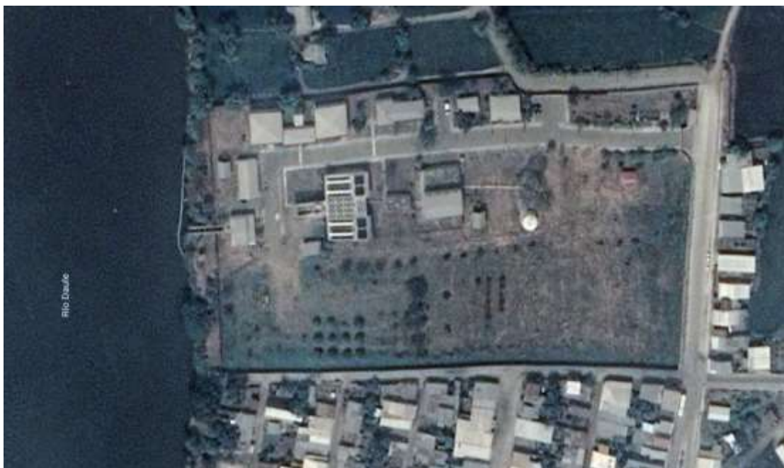
Figura 7. Ubicación PTAP de Daule
