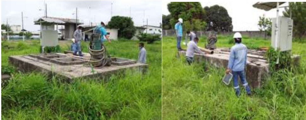
Figura 8. Almacenamiento de lodos de la PTAP Elaborado por: (Granoble Garcia & Tarira Santander, 2020)
