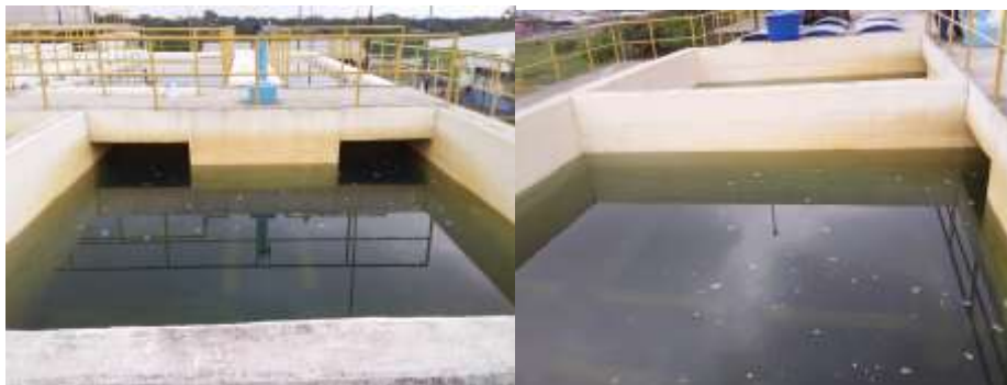
Figura 4. Proceso de sedimentación Elaborado por: (Granoble Garcia & Tarira Santander, 2020)
