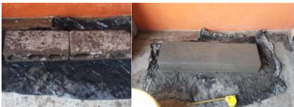
Figura 42. Enlucido con mortero tradicional de obra (1:4) Elaborado por: (Granoble Garcia & Tarira Santander, 2020)
