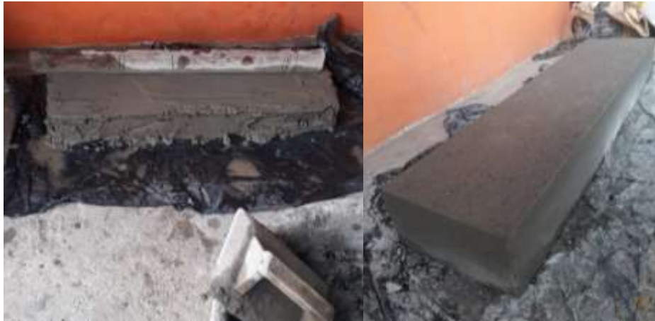
Figura 43. Enlucido con mortero PTAP (1:2:2) Elaborado por: (Granoble Garcia & Tarira Santander, 2020)
