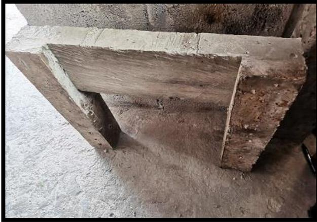
*Figura 89.* Viga de hormigón armado desencofrado.
