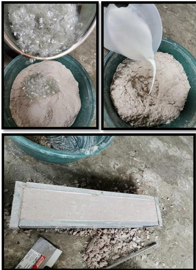
**Figura 52.** Mezcla y fundación del prototipo
