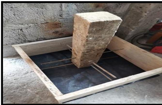
*Figura 84.* Colocación del prototipo (C.M.N.E) en plinto 0.50x0.50x0.20m.
