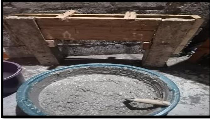
**Figura 86.** Hormigón 3/8 chispa 210 kg/cm<sup>2</sup>.
