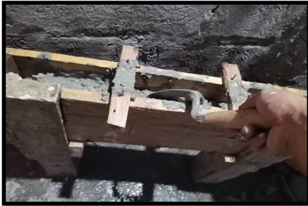
**Figura 87.** Colocación del hormigón 210 kg/cm<sup>2</sup>
