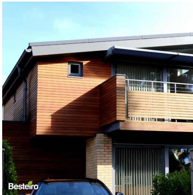
Ilustración 31. Fachada de Madera Fuente: (MBESTEIRO, 2018)
