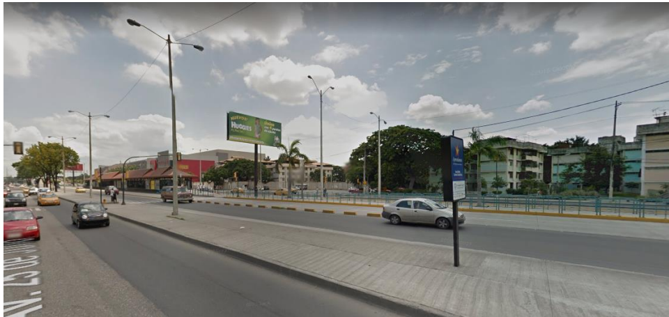
Ilustración 23. Metrovía de la Avenida 25 de Julio Fuente: (Google Earth, 2021)
