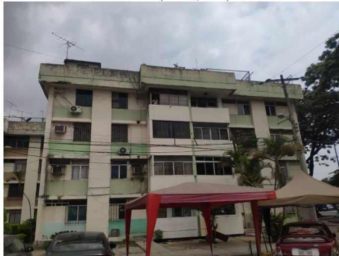
Ilustración 3. Bloque Multifamiliar Fachada Principal Elaborado por: García, P. y Gómez, C. (2021)
