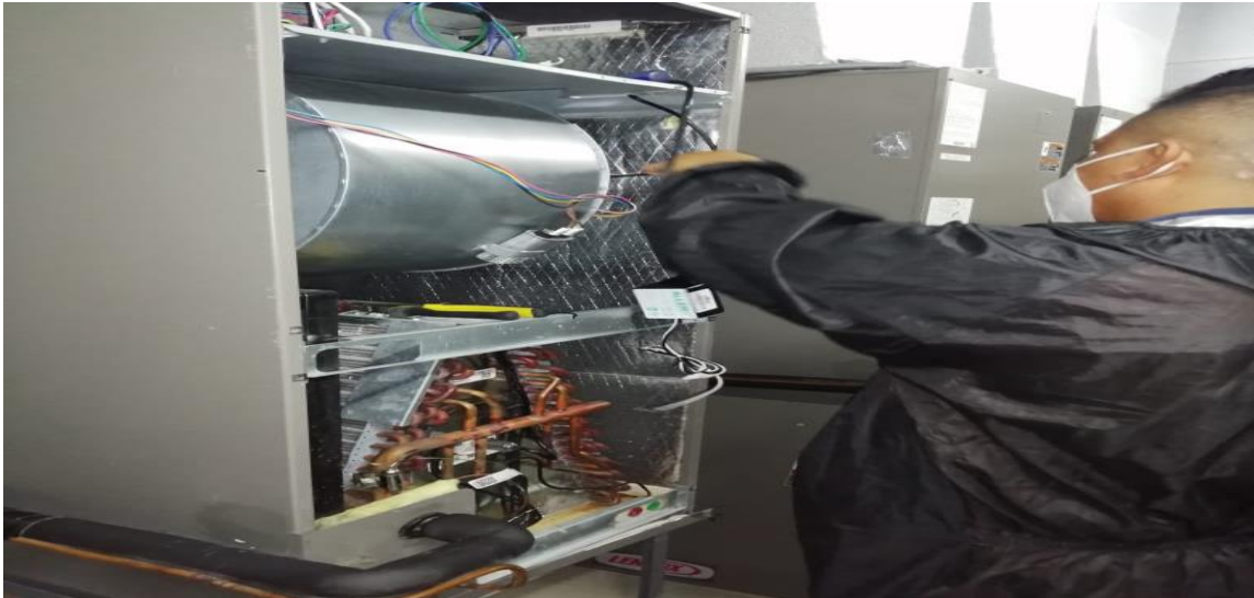
Figura 2. Reparación compresor aire acondicionado, tomado de la empresa HVAC INGENIERÍA S.A Elaborado por: Velasco (2020)
