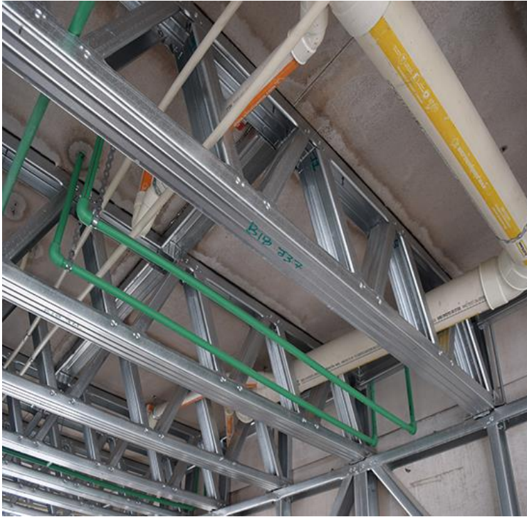
Figura 30. Instalación de Tuberías Fuente: (El Oficial, 2019)
