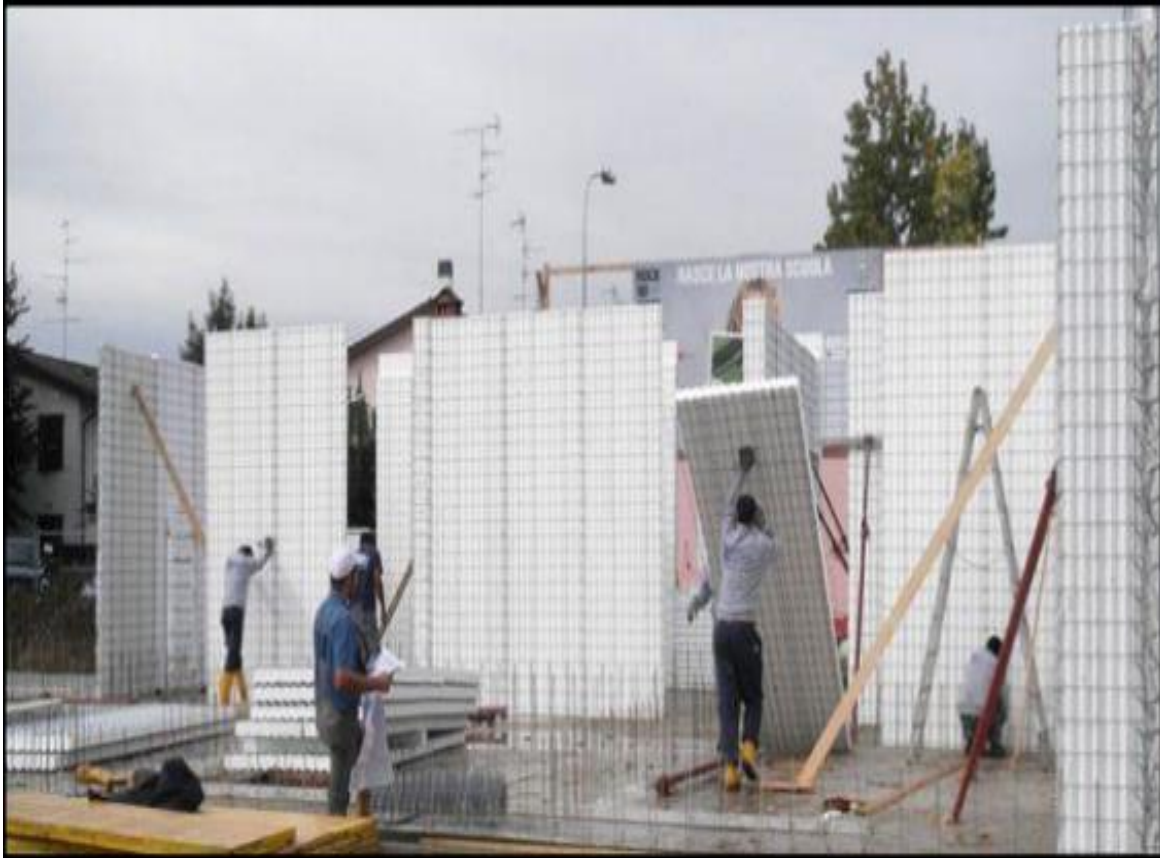
Figura 4. Ensamblaje De Paredes
