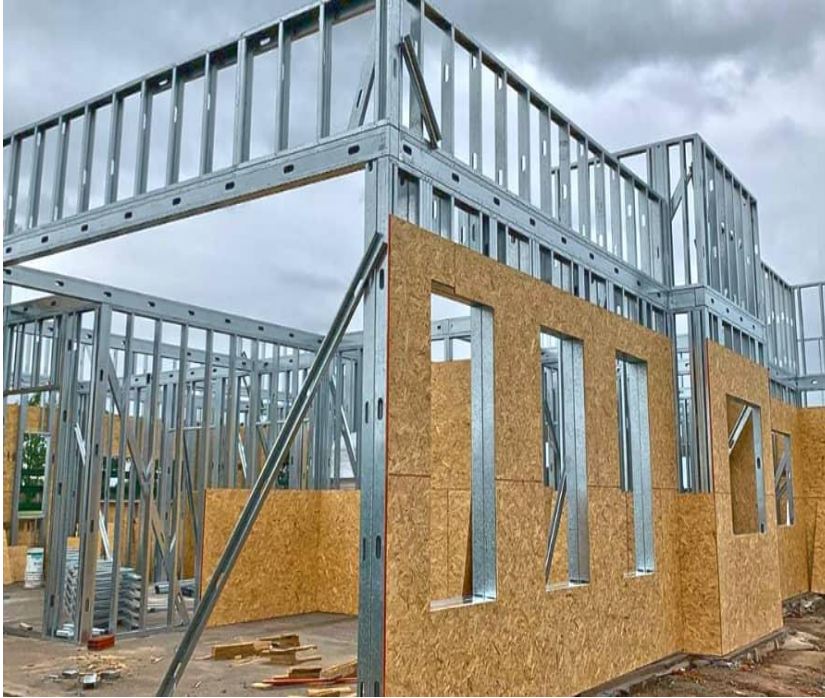
Figura 29. Instalación Tableros OSB Fuente: (DRYWALL S.A., 2020)
