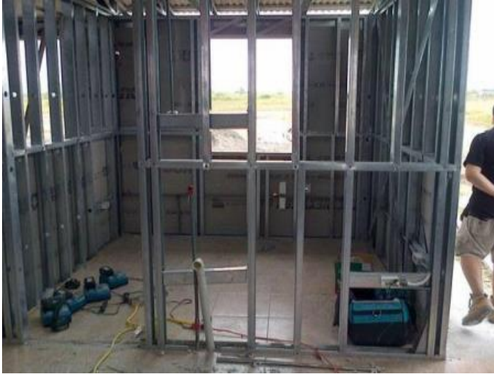
Figura 5. Estructura de Acero en Paredes Fuente: (Saavedra, 2016)
