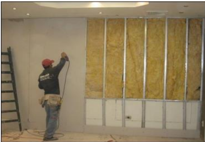
Figura 6. Instalación del Sistema Drywall. Fuente: (Pacheco, 2016)
