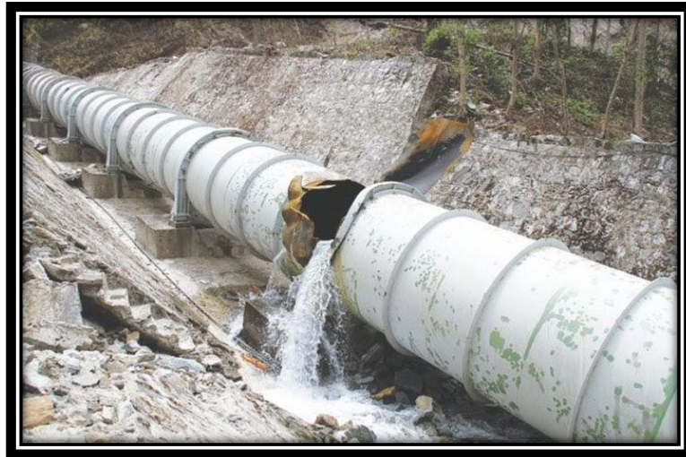
Figura 44. Mantenimiento Correctivo – rehabilitación tubería Elaborado por: Villafuerte, L. (2022)
