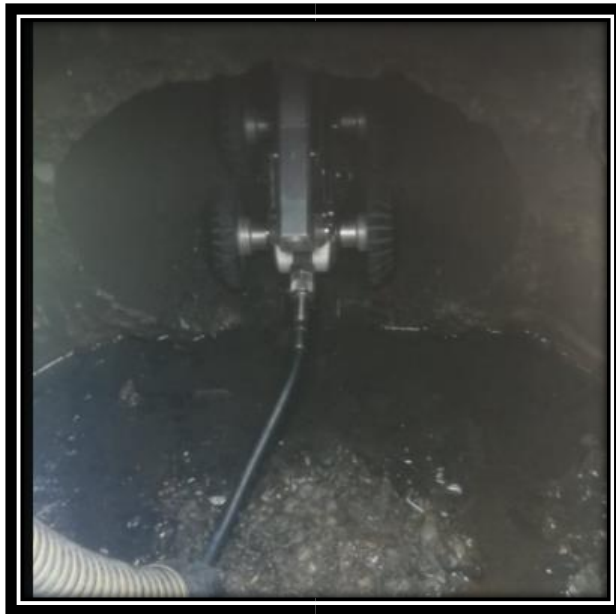
Figura 51. Ingreso del robot a la tubería Elaborado por: Villafuerte, L. (2022)
