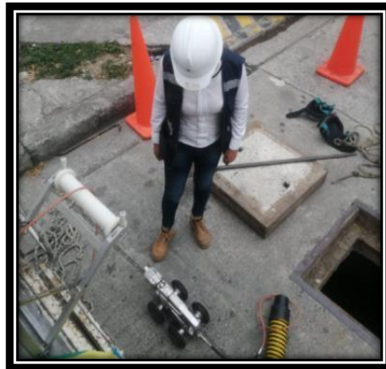
Figura 50. Inspeccion con robot Elaborado por: Villafuerte, L. (2022)
