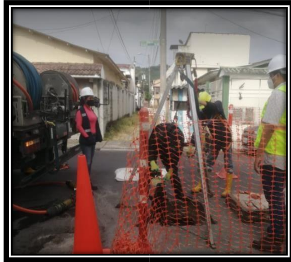
Figura 49. Limpieza con hidroclean Elaborado por: Villafuerte, L. (2022)
