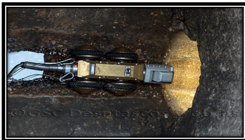
Figura 29. Inspección de alcantarillado equipos CCTV Elaborado por: Villafuerte, L. (2022)
