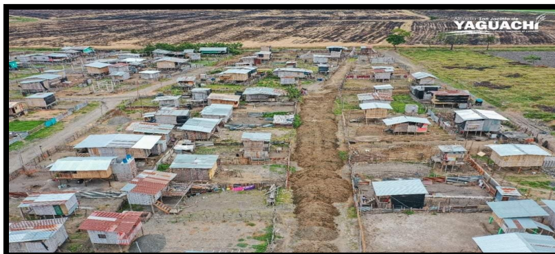
Imagen 6 Viviendas sin seguridad y en malas condiciones Fuente: GAD YAGUACHI.
