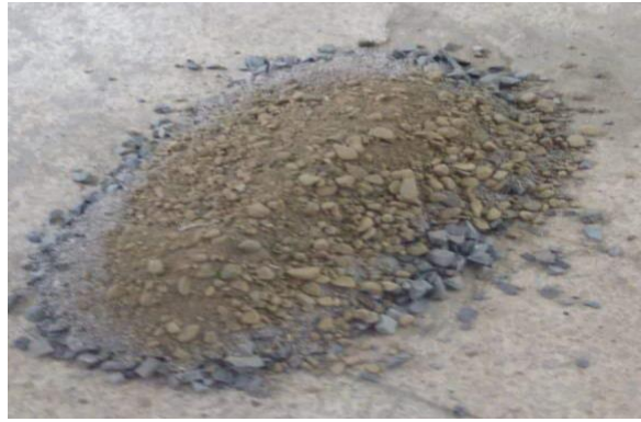
Figura 5 Dosificación de arena, cemento y ripio Elaborado por: Jhayya (2022).
