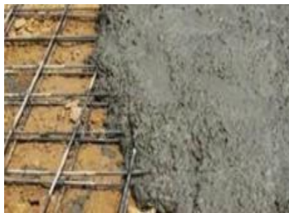
Figura 1 Hormigón Fuente: (Crespo, 2018)
