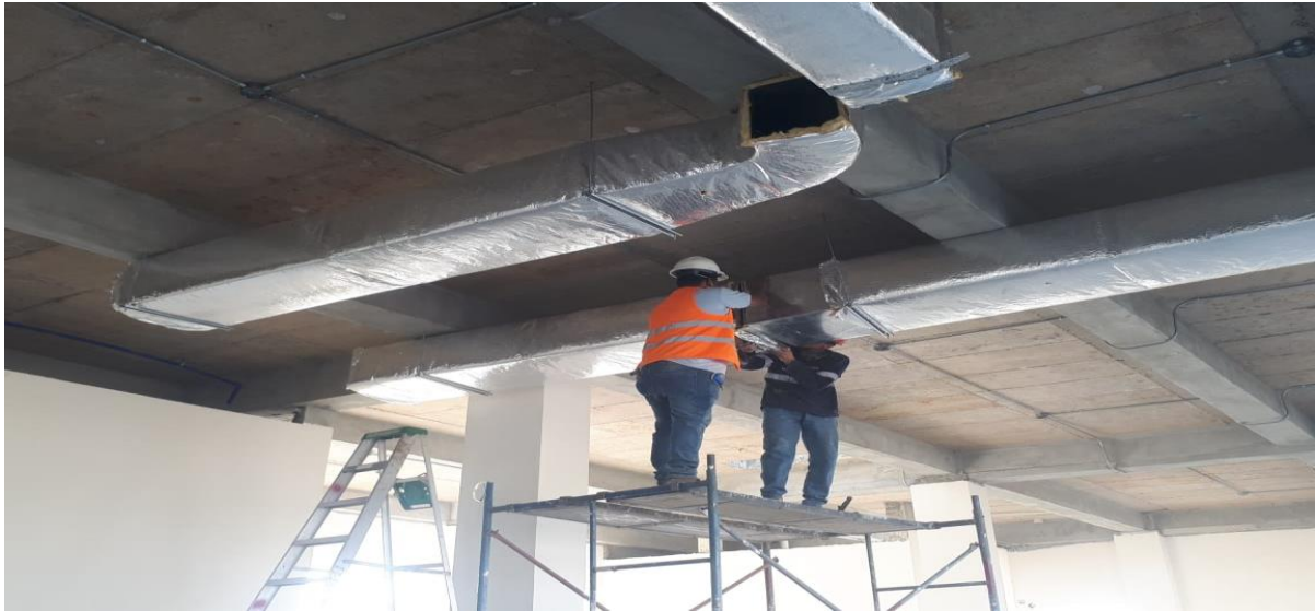
Figura 14. Mantenimiento de sistemas de climatización empresa HVAC INGENIERÍA S.A Fuente: Sitio web HVAC Ingeniería S.A
