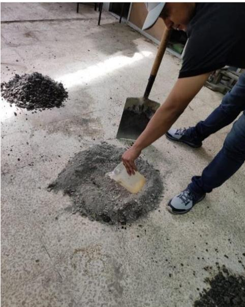
*Figura 30: Agua para la mezcla de hormigón*
