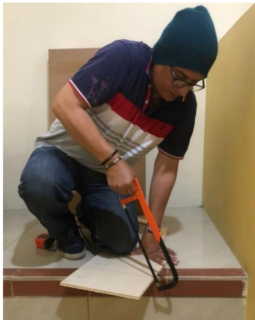
Figura 33 Realización del encofrado para el prototipo PTYH 03 Elaborado por: Contreras & Montalván (2022)
