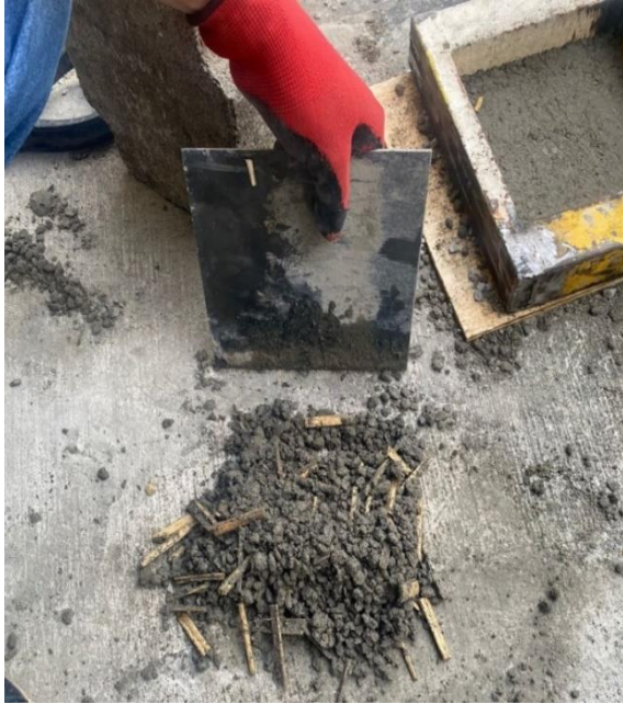
Figura 39 Realización de la mezcla para el hormigón prototipo PTYH 04 Elaborado por: Contreras & Montalván (2022)
