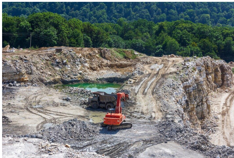
Figura 4. Excavadora y camión extrayendo yeso de la cantera Fuente: Gutaper (2022)
