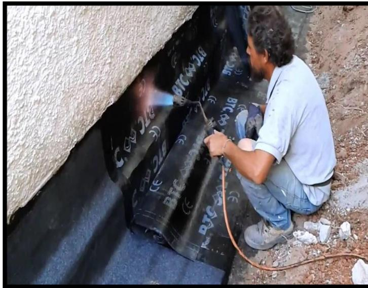
**Figura 11.** *Impermeabilización prefabricada en cimentación*
