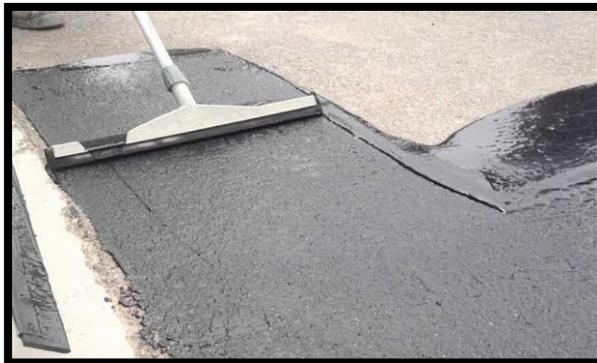
**Figura 10.** Sistema de impermeabilización asfáltico
