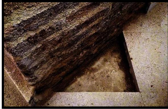
**Figura 8.** *Humedad por capilaridad en muro.*
