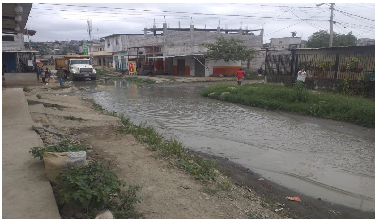
Figura 5. Calle de la entrada principal a la Cooperativa llena de agua y maleza. Elaborado por: Alvarado, R. y Romero, L. (2022).
